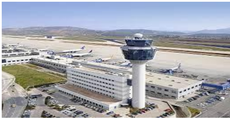
Εικόνα 2.20 Διεθνής αερολιμένας Ελευθέριος Βενιζέλος
