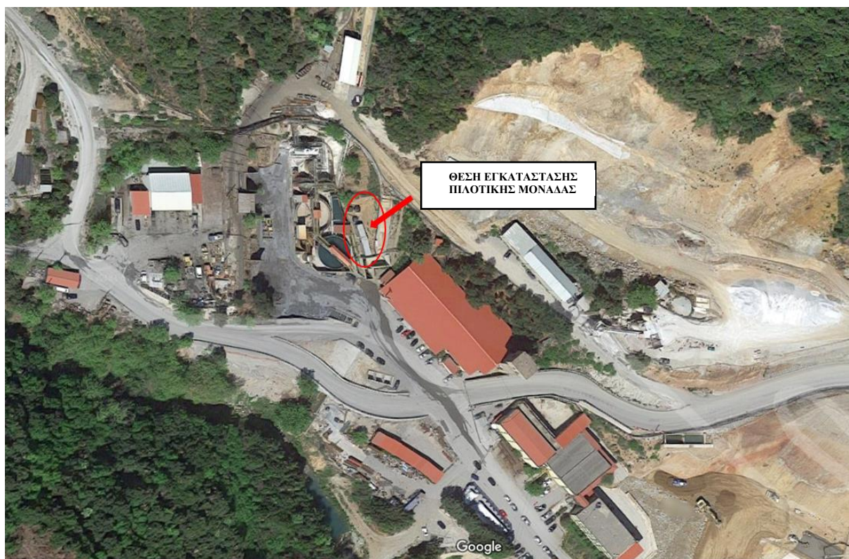
Φωτογραφία 6-5: Απεικόνιση του χώρου εγκατάστασης της πιλοτικής μονάδας για την πρόσθετη κατεργασία των νερών μεταλλείου Μαύρων Πετρών
