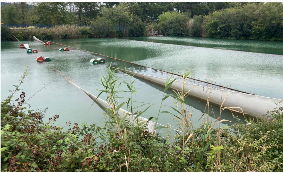
Φωτογραφία 5-4: 4 η λίμνη διαύγασης νερών Μεταλλείου Ολυμπιάδας - Ειδικά διαφράγματα από ύφασμα για την βελτίωση της απομάκρυνσης αιωρούμενων στερεών
