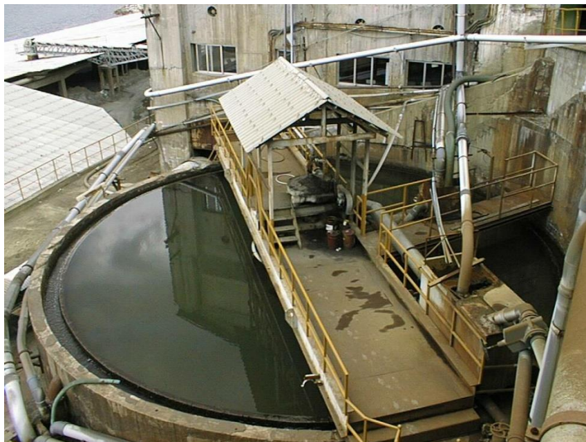
Φωτογραφία 5-13: Εφεδρικός Πυκνωτής Β' διαχωρισμού στερεών/υγρών
