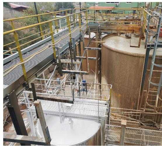
Αναδευόμενοι αναμεικτές εξουδετέρωσης και δεξαμενή αποθήκευσης πολφού υδρασβέστου
