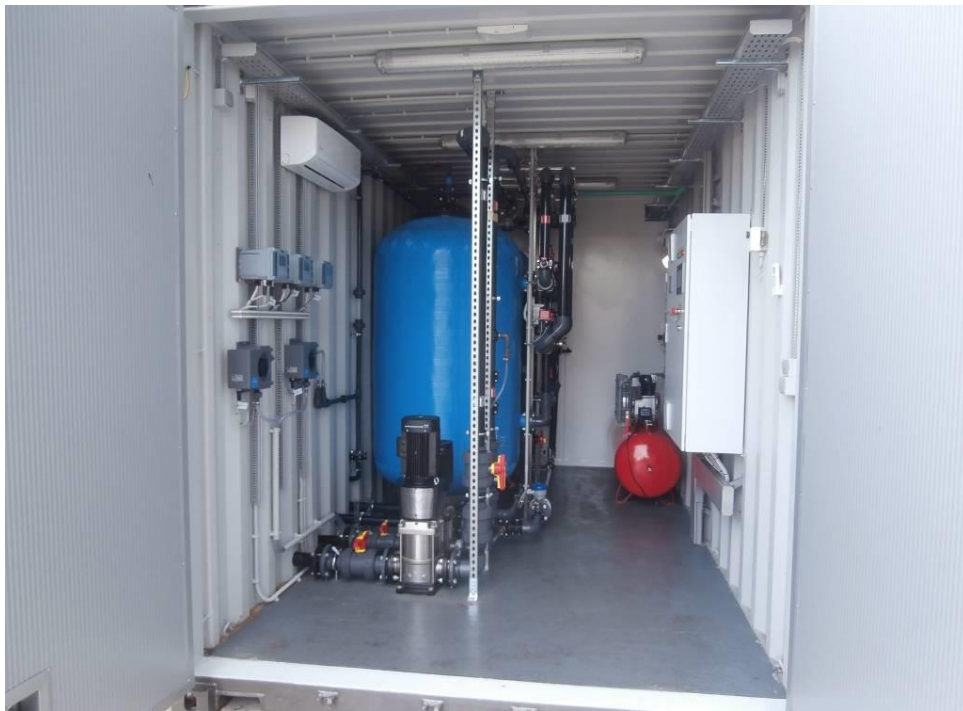
Φωτογραφία 6-1: Πιλοτική μονάδα για την πρόσθετη κατεργασία των νερών μεταλλείου Ολυμπιάδας - Απεικόνιση του σταδίου της φίλτρανσης (πολυστρωματικής διήθησης)
