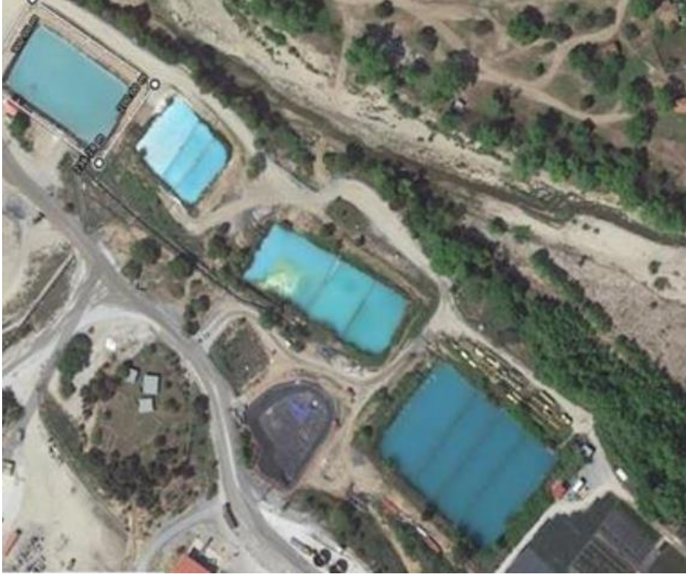
Φωτογραφία 5-3: Λίμνες διαύγασης νερών Μεταλλείου Ολυμπιάδας
