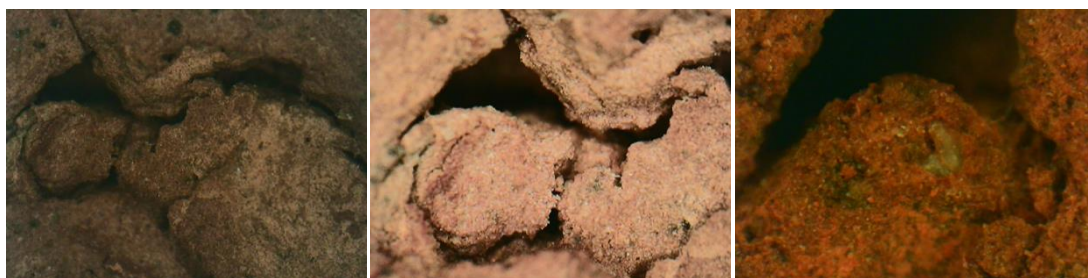
Εικόνα 14. Δείγμα 2. Ρωγμή (30x, 50x, 120x)
