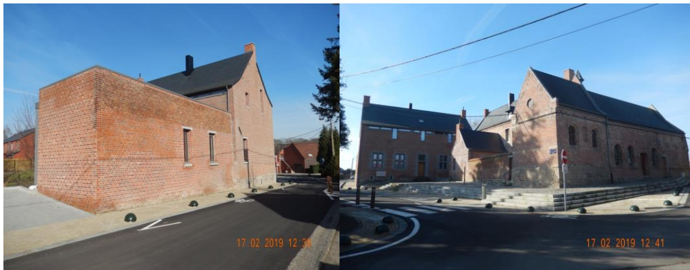
Εικόνα 10. Αποψη κτιρίου του πρώην νοσοκομείου Saint-Julien, Hainaut, Βέλγιο. Debailleux L. (ιδιωτικό αρχείο), 2019.
