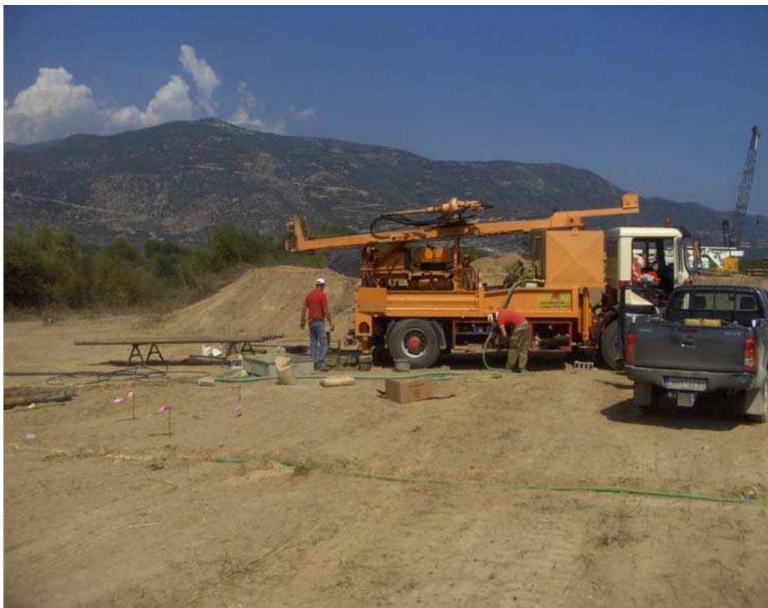
Σχήμα Β.6 Περιοχή τοποθέτησης για πιεζόμετρο Casagrande Pz-2.
