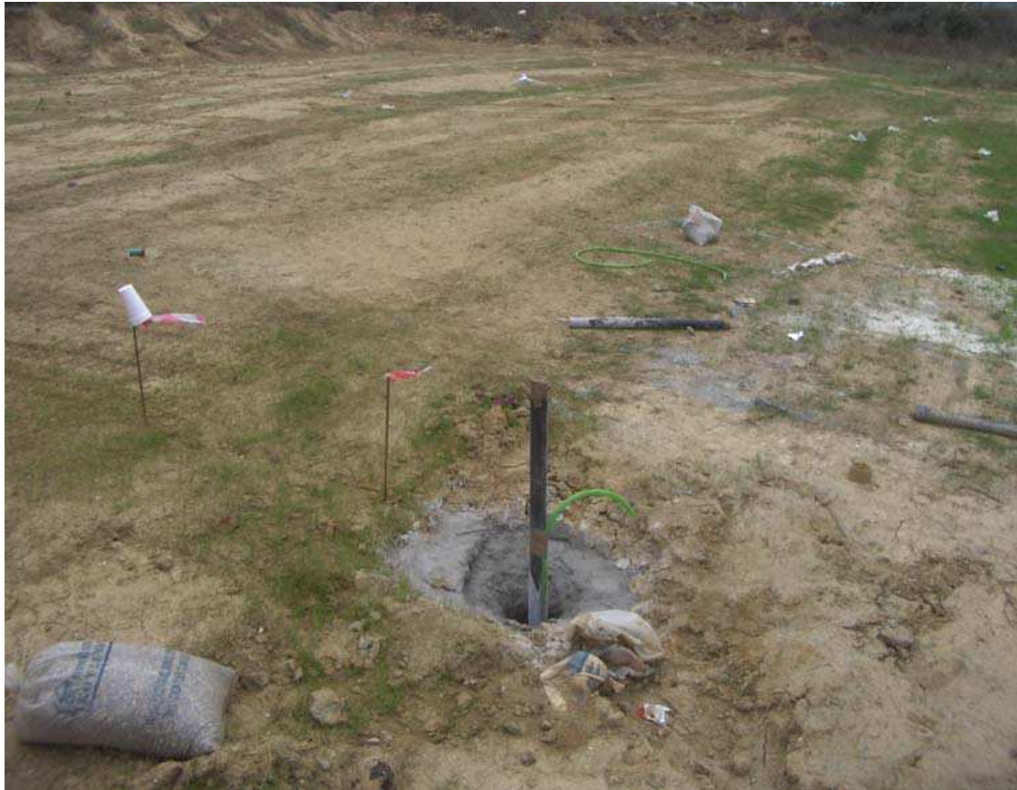
Σχήμα Β.5 Περιοχή τοποθέτησης για πιεζόμετρο Casagrande Pz-1.
