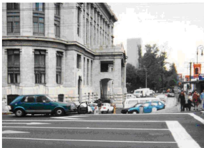
Εικόνα 4.1. Κτίριο στο Μεξικό, όπου καθιζήσεις συνεχίζουν ακόμα να παρατηρούνται.
