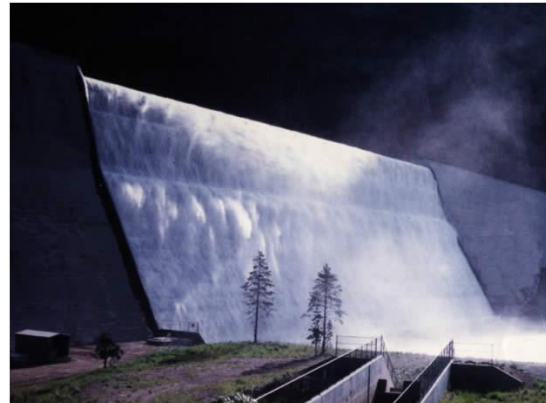
Εικόνα 3.5. Φράγμα Upper Stillwater, Γιούτα, ΗΠΑ
