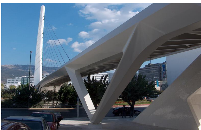
Σχ. 5.2: Βόρειο – Δυτική άποψη της γέφυρας
