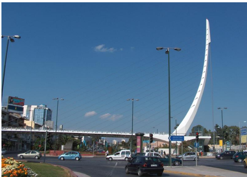
Σχ. 5.1: Νοτιο – Δυτική άποψη της γέφυρας
