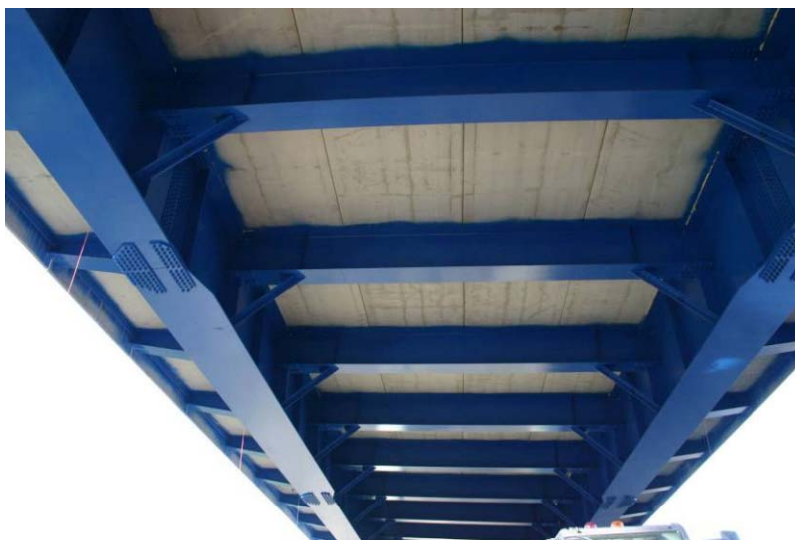
Σχ. A.6: Το κατάστρωμα της γέφυρας από κάτω
