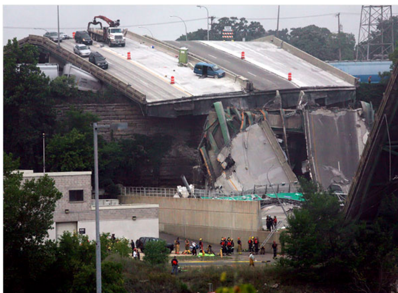
Σχ. 2.2: Κατάρρευση Γέφυρας 35W στην Μινεάπολη, Αμερική Fig. 2.2: Collapse of the 35W Bridge to Minneapolis, U.S.A.
