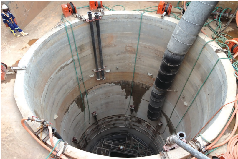
Εικόνα 2.3. Φρέαρ μεγάλων διαστάσεων (Shaft)
