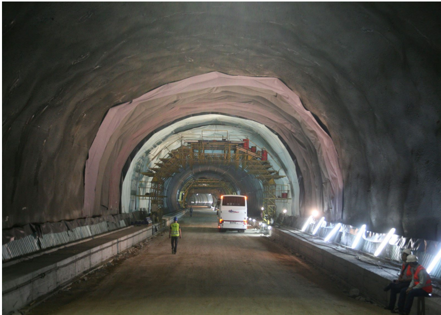
Εικόνα 2.1. Σήραγγα στα Τέμπη Λάρισης
