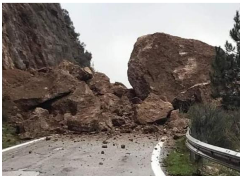
Εικόνα 19: Κατάπτωση Βράχων στην εθνική οδό Λάρισας-Θεσσαλονίκης (2022).
