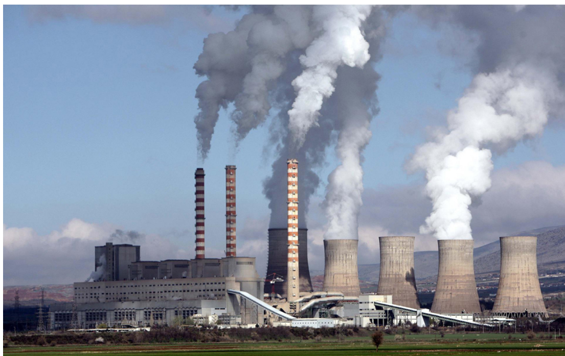
Εικόνα 18: Ατμοηλεκτρικός Σταθμός στην Πτολεμαΐδα ( https://www.kathimerini.gr/ )
