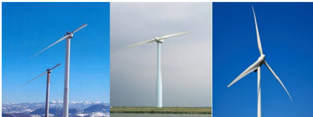
Εικόνα 3: Ανεμογεννήτριες HAWT ενός, δύο και τριών πτερυγίων (Wind-turbine-models.com)
