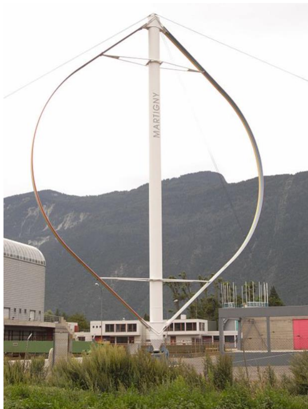
Σχήμα 1. Ανεμογεννήτρια κατακόρυφου άξονα τύπου Darrieus. Πηγή : Lysippos, Wikimedia Commons author (GNU free documentation license) (public domain)
