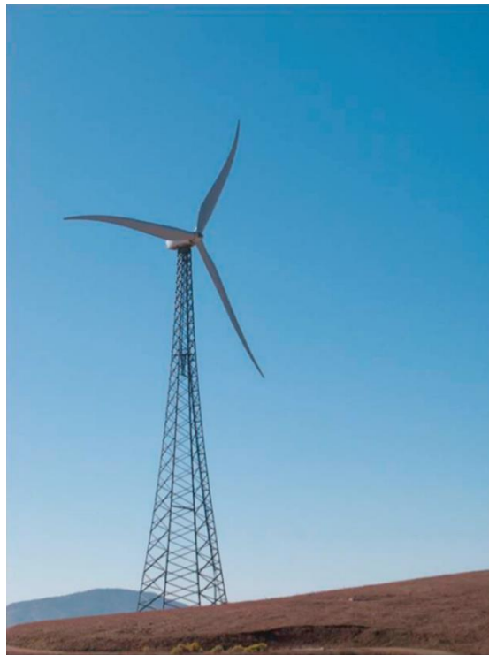
Σχήμα 4. Ανεμογεννήτρια οριζόντιου άξονα με κυρτά πτερύγια. Πηγή: CA 2008 (photo by H. Shiu).
