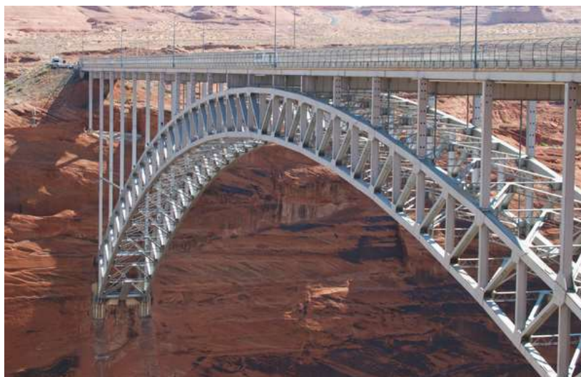
Εικόνα 1.9α: Glen Canyon Dam Bridge
