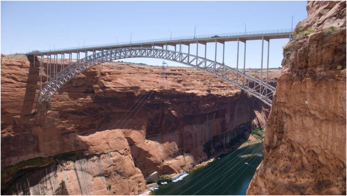
Εικόνα 1.9β: Glen Canyon Dam Bridge
