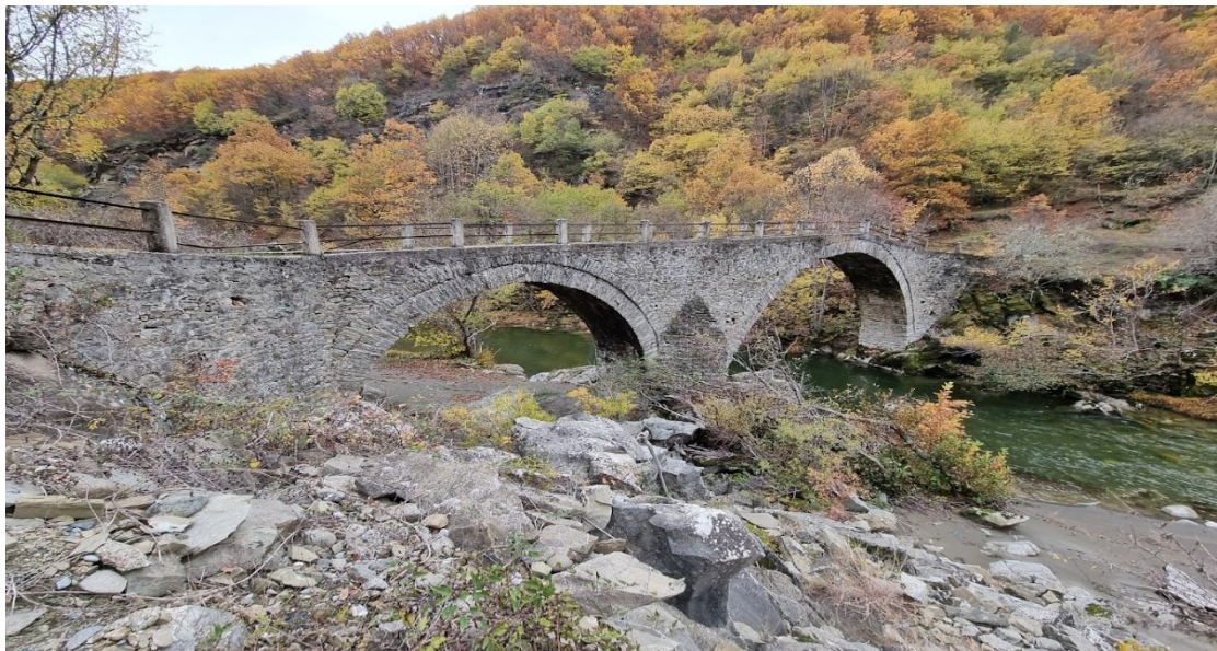
Εικόνα 3.2: Γεφύρι του Καγκέλια (Πηγή: www.visitgrevena.gr )
