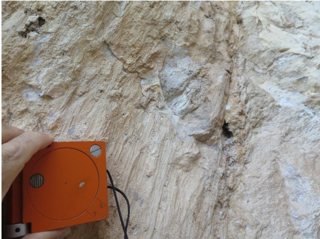
Φωτογραφία 5-12: Γραμμές ολίσθησης ή γραμμές λόγω τριβής επάνω στο ασβεστίτικο υλικό
