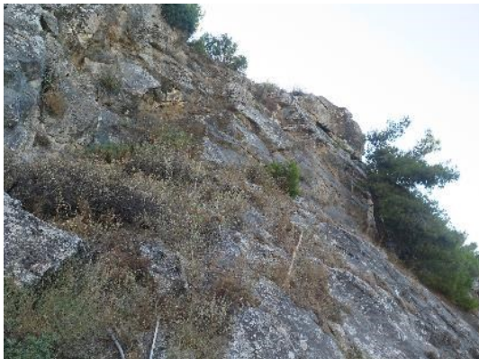
Φωτογραφία 5-5: Άκρο του δεξιού πρηνούς στο οποίο διαφαίνεται ένα τεμάχιο βραχοσφήνας το οποίο με τις κατάλληλες συνθήκες θα εκδηλώσει επίπεδη ολίσθηση
