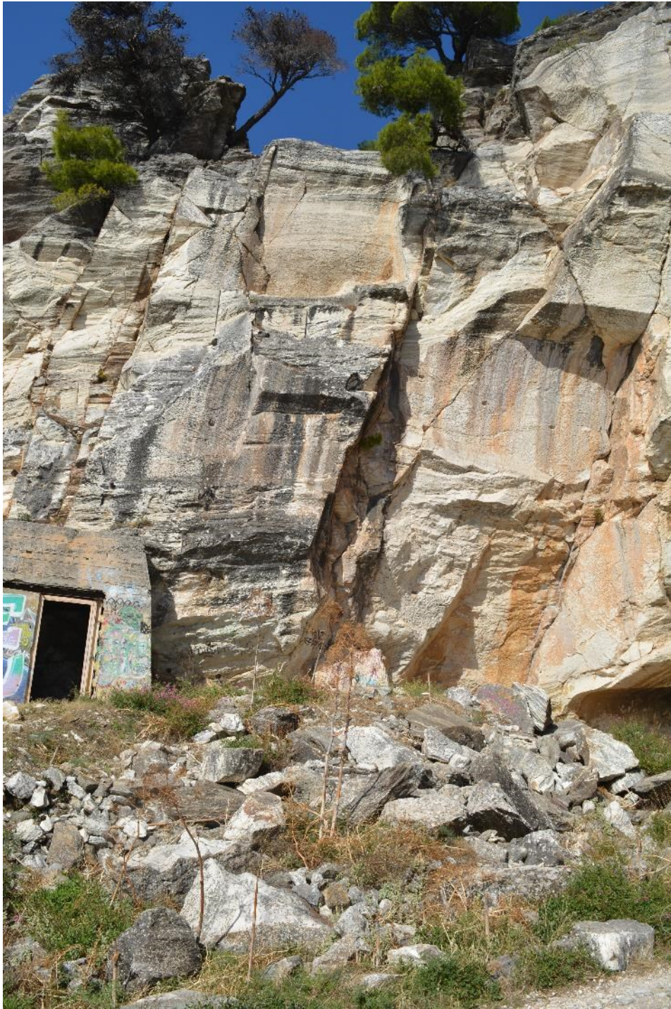
Φωτογραφία 5-8: Κατακόρυφες ασυνέχειες στο αριστερό πρηνές
