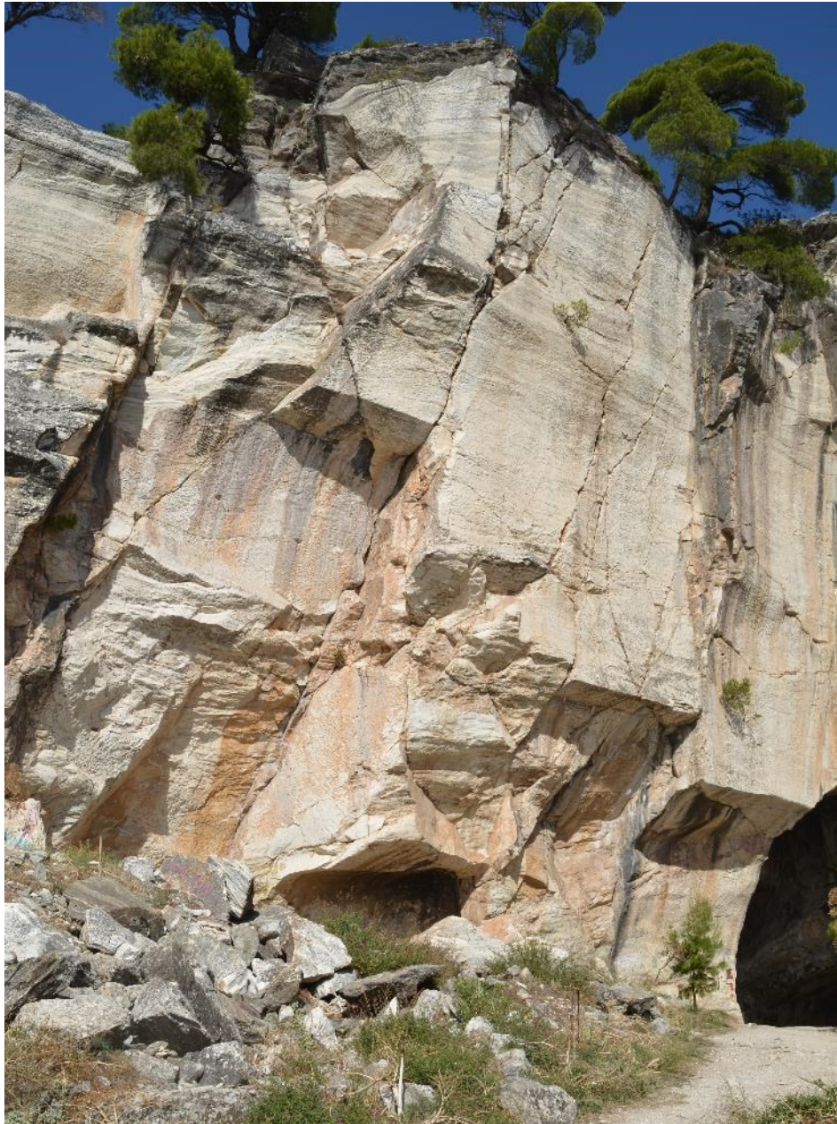
Φωτογραφία 5-7: Κατακόρυφες ασυνέχειες στο αριστερό πρανές
