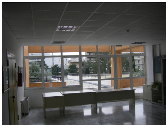
Εικ.60: Νότια ανοίγματα δεύτερου ορόφου
