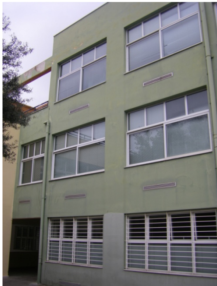
Εικ. 59: Νότια ανοίγματα κτιρίου Βέη
