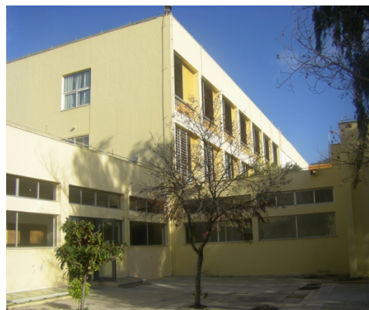
Εικ. 56:Νότια ανοίγματα ισογείου
