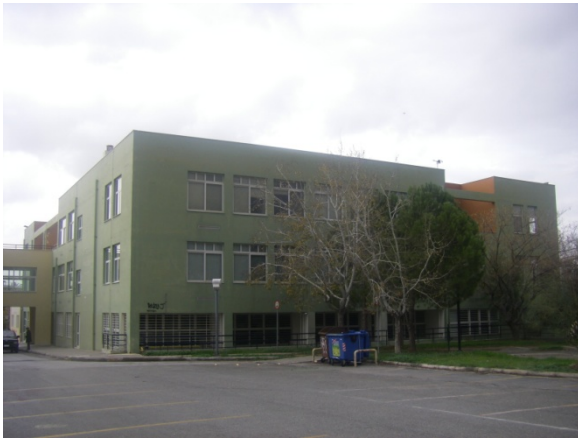
Εικ. 40 Νοτιοανατολική πλευρά κτιρίου Βέη
