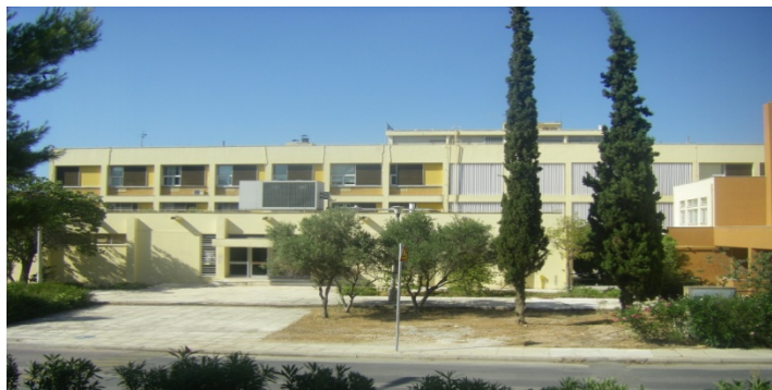
Εικ. 37: Νότια όψη κτιρίου Λαμπαδαρίου
