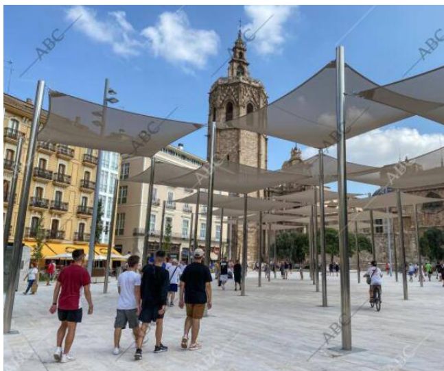
Εικόνα 10: Τοποθέτηση αφαιρούμενων τεντών στην πλατεία της Plaza de la Reina για την εξασφάλιση σκιάς στην περιοχή
