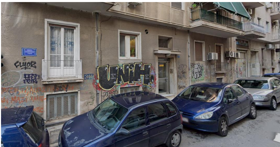
Εικόνα 57: Πολυκατοικίες στην περιοχή μελέτης που υποβαθμίζουν την αισθητική της περιοχής λόγω των γκράφιτι στους τοίχους.
