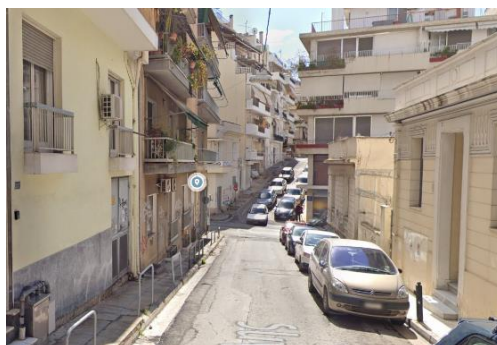
Εικόνα 38: Τυχαία οδός στην περιοχή της Κυψέλης όπου οι πολυκατοικίες διαφέρουν ως προς το ύψος και τα χαρακτηριστικά των κτηρίων
