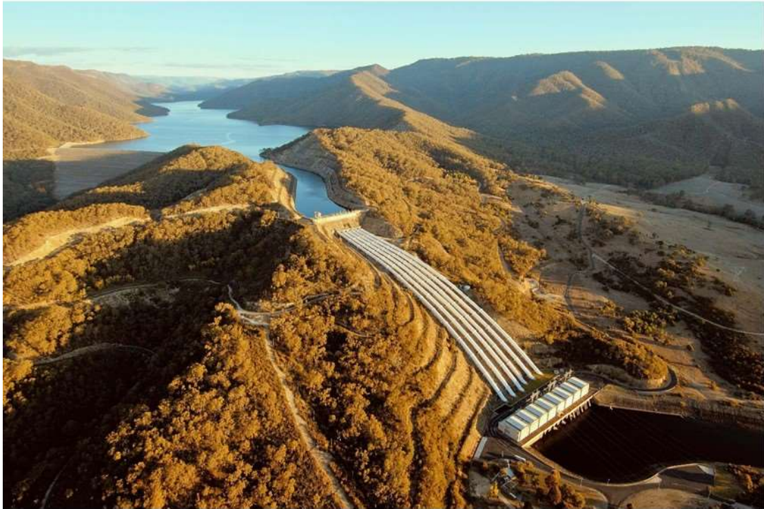
Σχήμα 3.2 : Υδροηλεκτρική αποθήκευση με άντληση [11]
