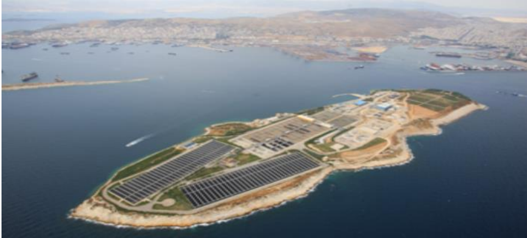
Εικόνα 3.1.2. Κέντρο Επεξεργασίας Λυμάτων Ψυττάλειας (ΚΕΛΨ) (Ε.ΥΔ.ΑΠ. - eydap.gr)
