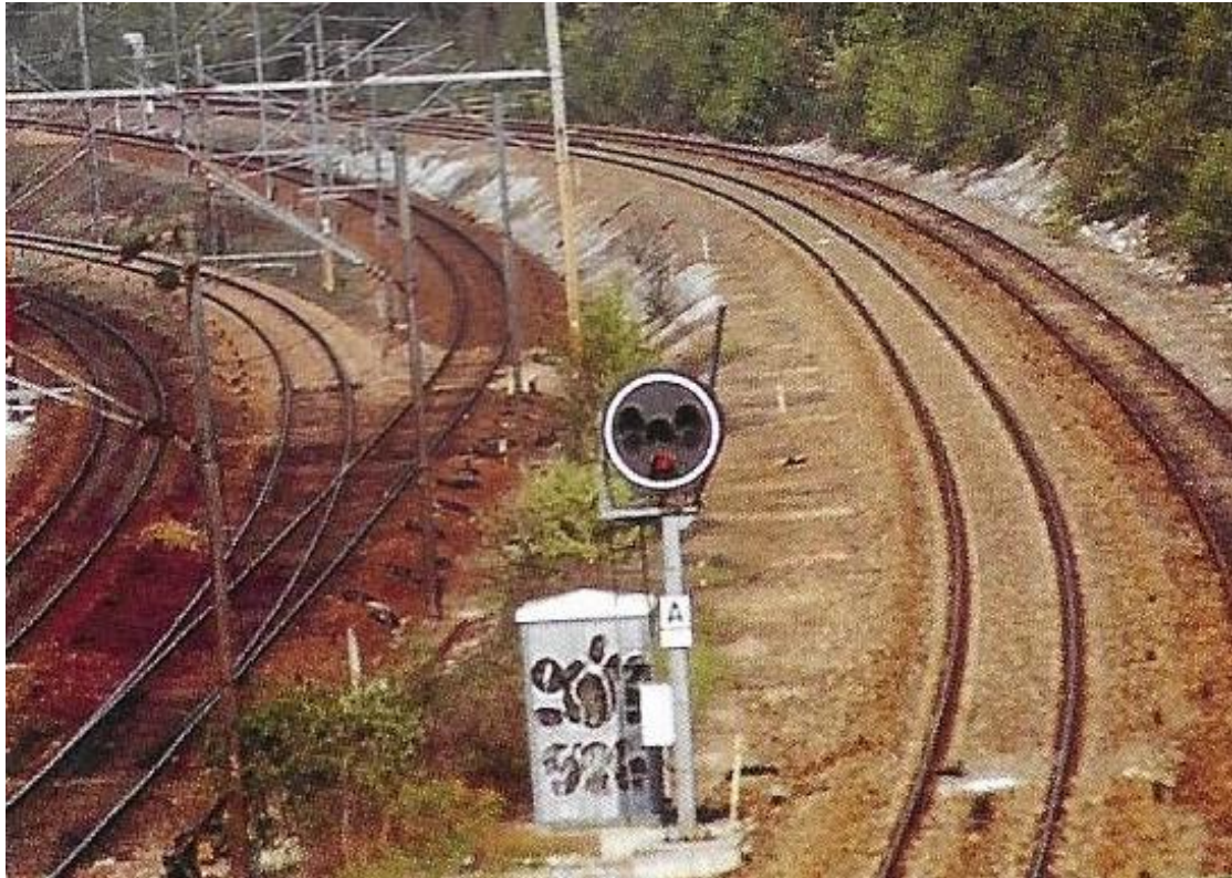
Εικόνα 2.2:Τυπικό Σιδηροδρομικό Επίχωμα στη Γερμανία (Πηγή: Wikipedia)
