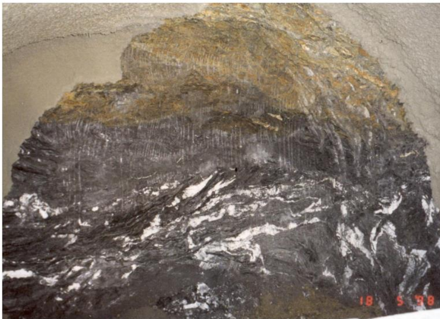
Εικόνα 42 Επαφή γκριζοπράσινου μετα – ψαμμίτη (Ανώτερου Αθηναϊκού Σχιστόλιθου) με τεφρό γκρίζο αργιλικό σχιστόλιθο (Κατώτερου Αθηναϊκού Σχιστόλιθου) σε μέτωπο εκσκαφής της Γραμμής 3, μεταξύ σταθμών «Μοναστηράκι» και «Κεραμικός». Έντονη εμφάνιση λευκών πτυχωμένων φακών χαλαζία στον σχιστόλιθο. (Boronkay et al., 2021)
