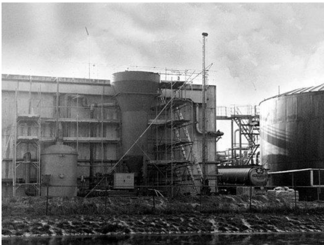
Σχήμα 4.3 – Μονάδα παραγωγής και επεξεργασίας τροφίμων της AVEBE στην Ολλανδία (Giesen, 2009)
