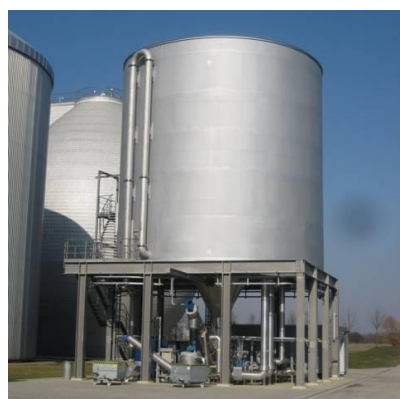
Σχήμα 4.8 – Μέθοδος AirPrex μαζί με τον αντιδραστήρα που λαμβάνει χώρα η επεξεργασία (Heinzmann 2009)
