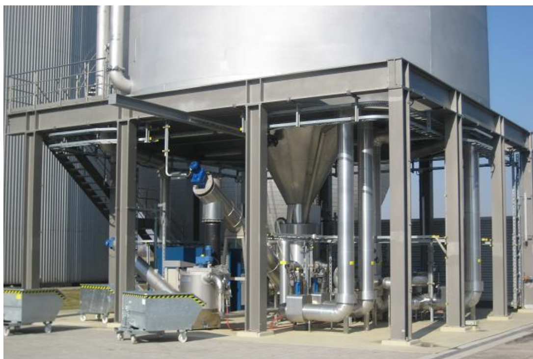
Σχήμα 4.12 – Το κάτω μέρος του αντιδραστήρα της μεθόδου AirPrex (Nieminen, 2010, Hanneman, 2009)
