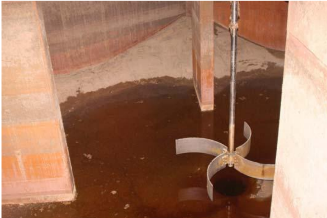
Σχήμα 4.14 – Σχηματισμός στρουβίτη με την μορφή χαλικιών σε δεξαμενή χώνεψης στην μονάδα επεξεργασίας λυμάτων στο Durham του Oregon των ΗΠΑ (Britton et al. 2010)
