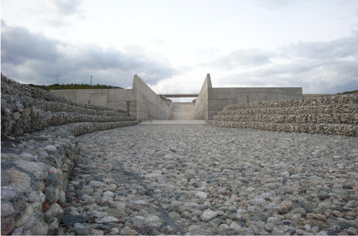
Σχήμα 2.13: Κατάντη όψη του υπερχειλιστή (πηγή: www.een-gadoura.gr )
