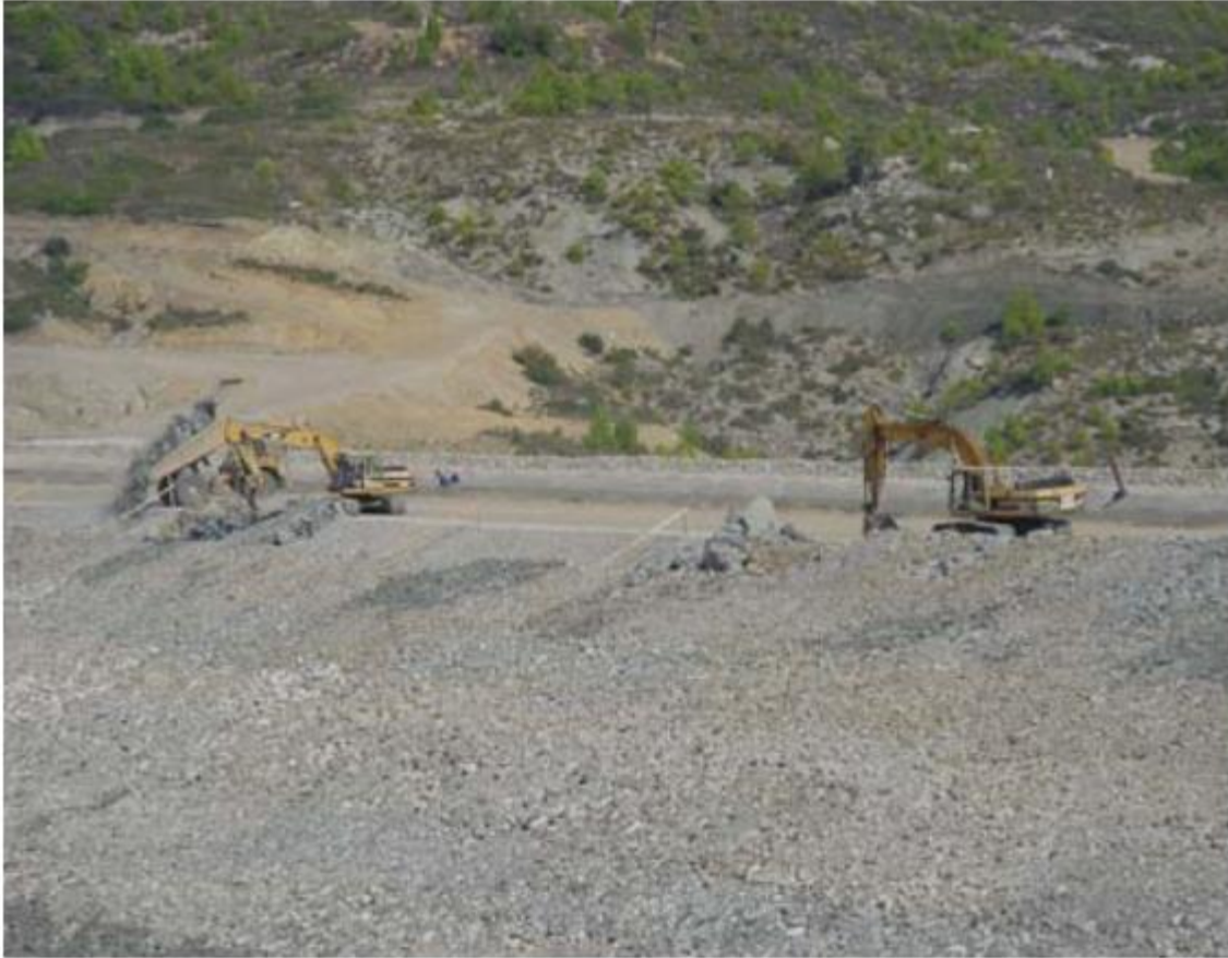
Σχήμα 2.7: Κατασκευή ζώνης προστασίας κυρίως φράγματος (πηγή: ΑΕΓΕΚ, 2003)
