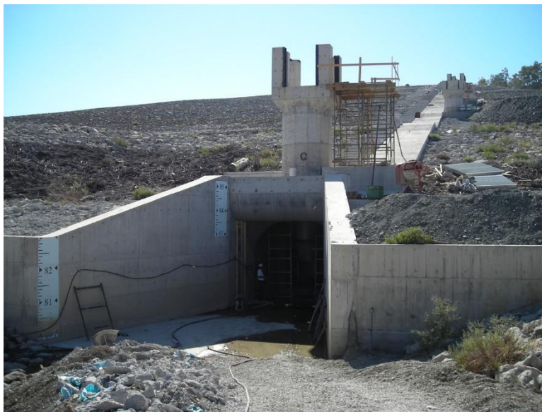
Σχήμα 2.8: Κατασκευή τμήματος εισόδου της σήραγγας εκτροπής (πηγή: sofios.gr)
