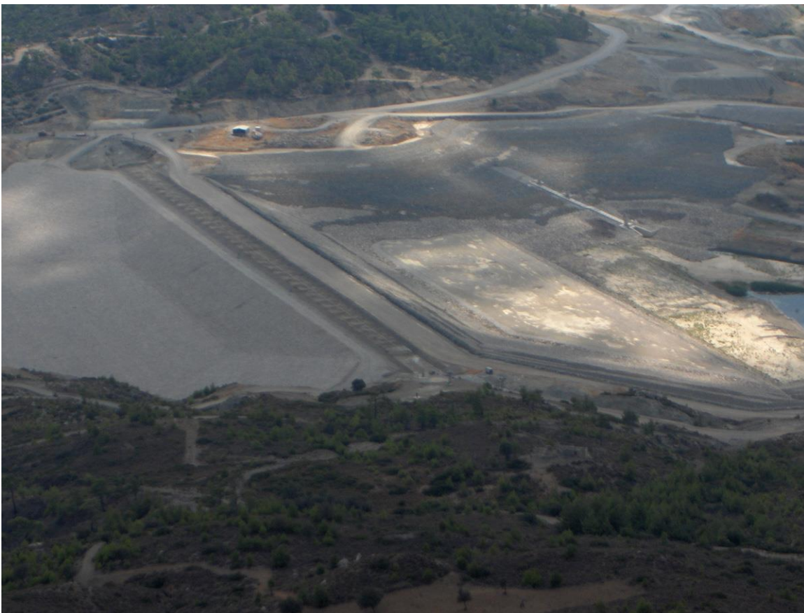
Σχήμα 2.4: Ζώνες χωμάτινου φράγματος Γαδουρά κατά την κατασκευή (πηγή: een-gadoura.gr )
