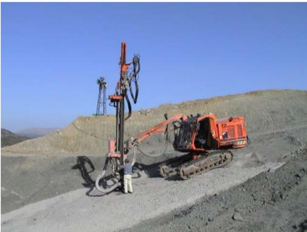
Σχήμα 2.5: Τσιμεντένεση τάπητα (πηγή: ΑΕΓΕΚ, 2001)
