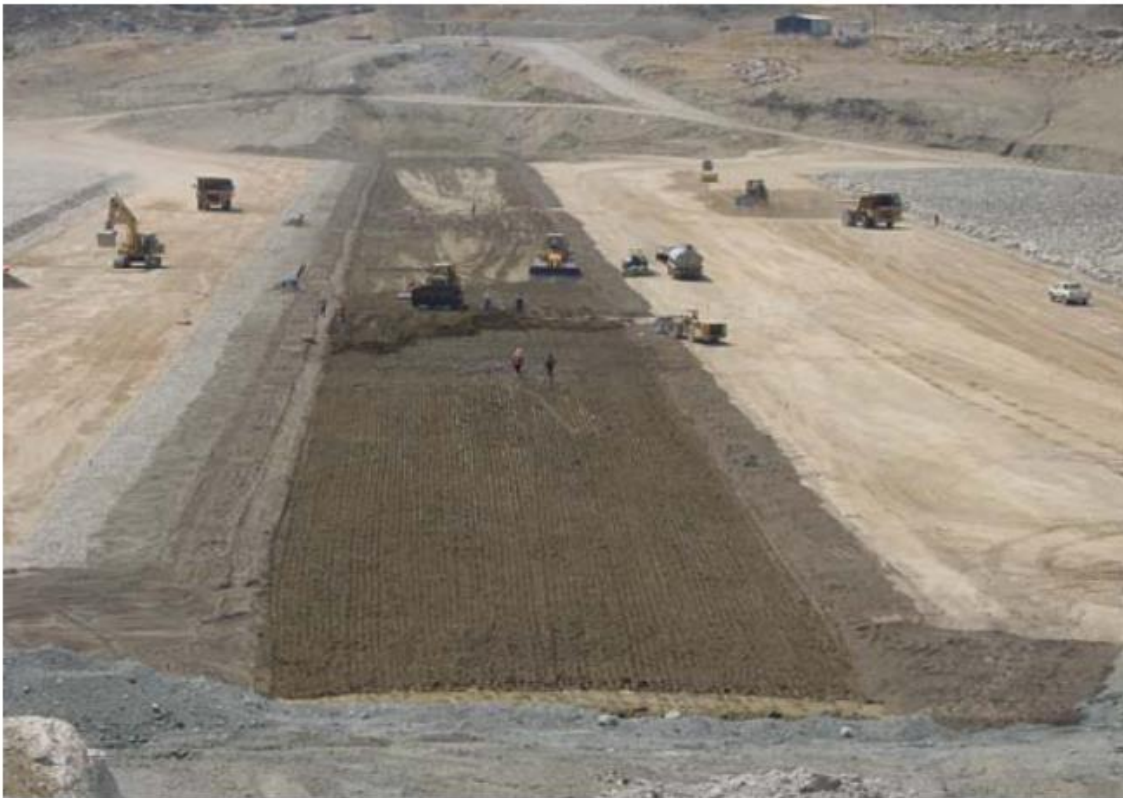
Σχήμα 2.6: Κατασκευή ζωνών κυρίως φράγματος (πηγή: ΑΕΓΕΚ, 2002)
