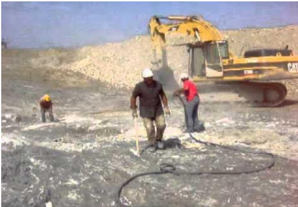
Σχήμα 2.11: Κατασκευή αυχενικού φράγματος (πηγή: ΑΕΓΕΚ, 2001)
