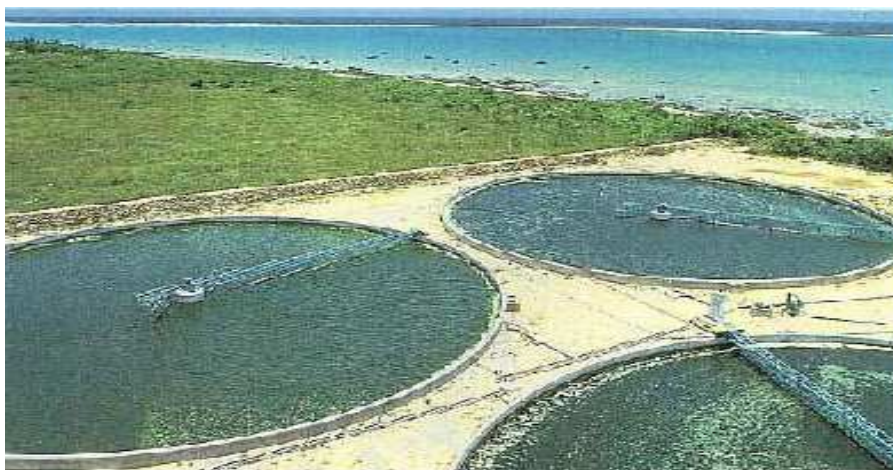
Εικόνα 3.4: Κυκλικές λίμνες 500 m 2 για την παραγωγή του είδους Chlorella (Ιαπωνία) Προέλευση: T. J. Lundquist, 2007 μετά από προσαρμογή.
