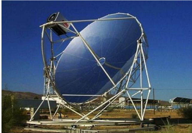
Εικόνα 3.3: Ο ηλιακός συλλέκτης παραβολικού πιάτου EuroDish Stirling. Μερικά χαρακτηριστικά: διάμετρος 8,5 m, επιφάνεια 56,7 m 2 , μέσος συντελεστής συγκέντρωσης 2500 [94].
