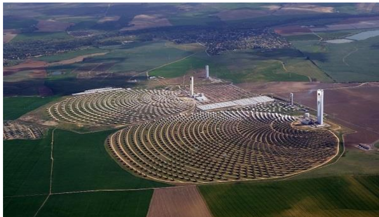
Εικόνα 3.6: Διάταξη Ηλιοστατικού Πεδίου Βόρεια του Πύργου (North Field Layout) του σταθμού PS10, στη Σεβίλλη Ισπανίας.
