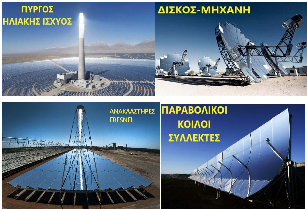
Εικόνα 3.1: Τυπικά συστήματα των διάφορων Συγκεντρωτικών Ηλιοθερμικών Συστημάτων
