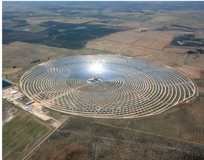
Εικόνα 3.5: Περιβάλλουσα Διάταξη Ηλιοστατικού Πεδίου του σταθμού Gemasolar, στη Σεβίλλη Ισπανίας [112].
