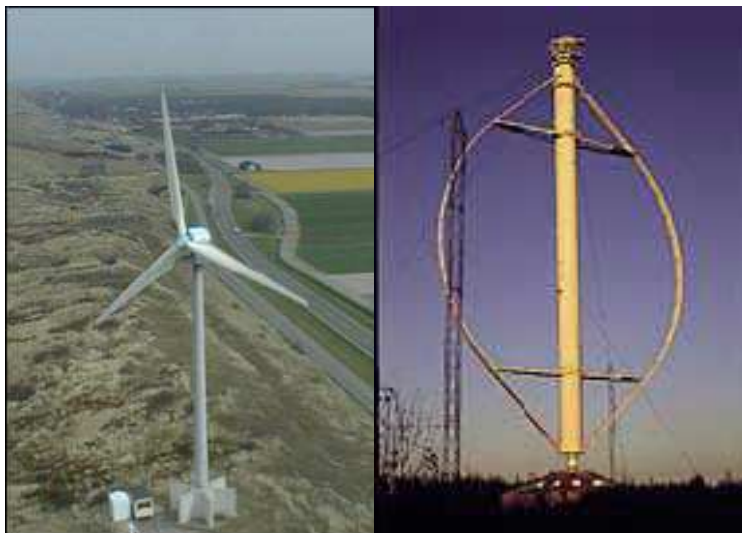
Εικόνα 3.1.1: Ανεμογεννήτριες οριζόντιου – κατακόρυφου άξονα (itia.ntua.gr)
