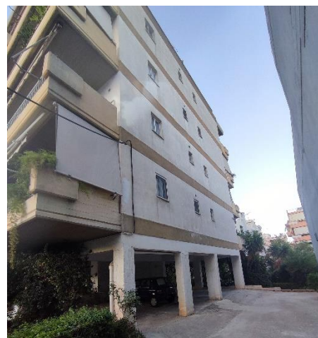
εικ.9&10 τυπικό κτίριο με πιλοτή ως χώρο στάθμευσης, Αθήνα (φωτ.Γιώργος Παπαγεωργίου)
