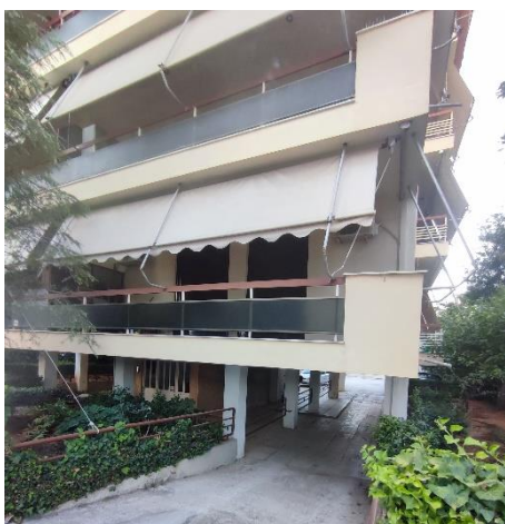
εικ.9&10 τυπικό κτίριο με πιλοτή ως χώρο στάθμευσης, Αθήνα (φωτ.Γιώργος Παπαγεωργίου)
