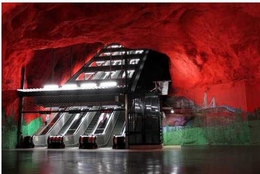
Εικόνα 3.3 Τελική επένδυση από εκτοξευόμενο σκυρόδεμα (Σταθμός Μητροπολιτικού Σιδηρόδρομου Στοκχόλμης).
