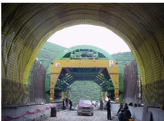
Εικόνα 3.11 Οπλισμός τελικής επένδυσης (Σήραγγα Σ13, Πηγή: ΤΙΑΣ, Μαρίνος Β., 2007).
