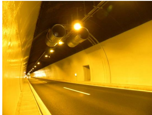
Εικόνα 3.2 Τελική επένδυση από άοπλο σκυρόδεμα (Σήραγγα Αρτεμισίου, Αυτοκινητόδρομος Μορέας).
