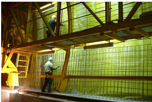
Εικόνα 3.7 Οπλισμός τελικής επένδυσης (Σήραγγα Σ13, Πηγή: ΤΙΑΣ, Μαρίνος Β., 2007).
