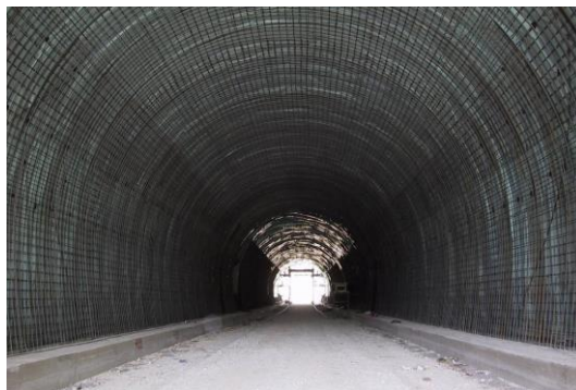
Εικόνα 3.8 Οπλισμός τελικής επένδυσης (Σήραγγα Σ13, Πηγή: ΤΙΑΣ, Μαρίνος Β., 2007).
