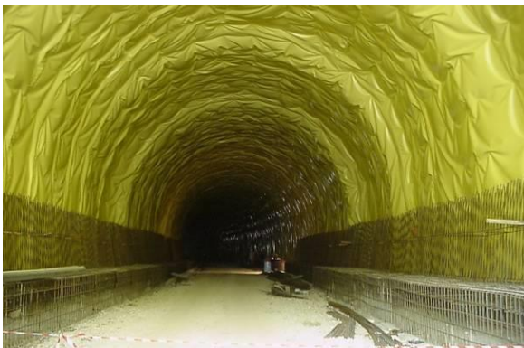
Εικόνα 3.5 Στεγανωτική μεμβράνη πριν την τοποθέτηση του οπλισμού. Διακρίνεται ο οπλισμός των πεδίων (Σήραγγα Σ13, Πηγή: ΤΙΑΣ, Μαρίνος Β., 2007).
