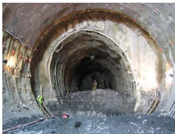
Εικόνα 5.6 Παραμορφωμένη διατομή εξαιτίας των εκεταμένων συγκλίσεων στη σήραγγα πρόσβασης Saint Martin La Porte στη σήραγγα βάσης Lyon - Turin (Barla et al., 2010).
