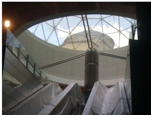
Εικόνα 6.10 Γυάλινος θόλος στην οροφή του Σταθμού Περιστερίου με σκοπό την εξασφάλιση του φυσικού φωτισμού του σταθμού και την ανάδειξη του Ναού Ευαγγελιστρίας.
