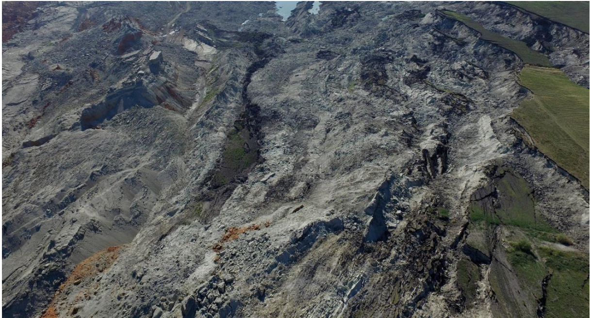
Εικόνα 7. Αποψη του βορειοδυτικού τμήματος της εκσκαφής, στο οποίο παρατηρείται απουσία υδάτων εξαιτίας των αποστραγγιστικών έργων (Loupasakis, 2020).
