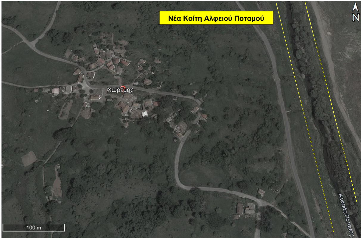
Εικόνα 10. Αποψη της περιοχής Χωρέμη και της νέας κοίτης του Αλφειού Ποταμού ύστερα από την εκτροπή του.
