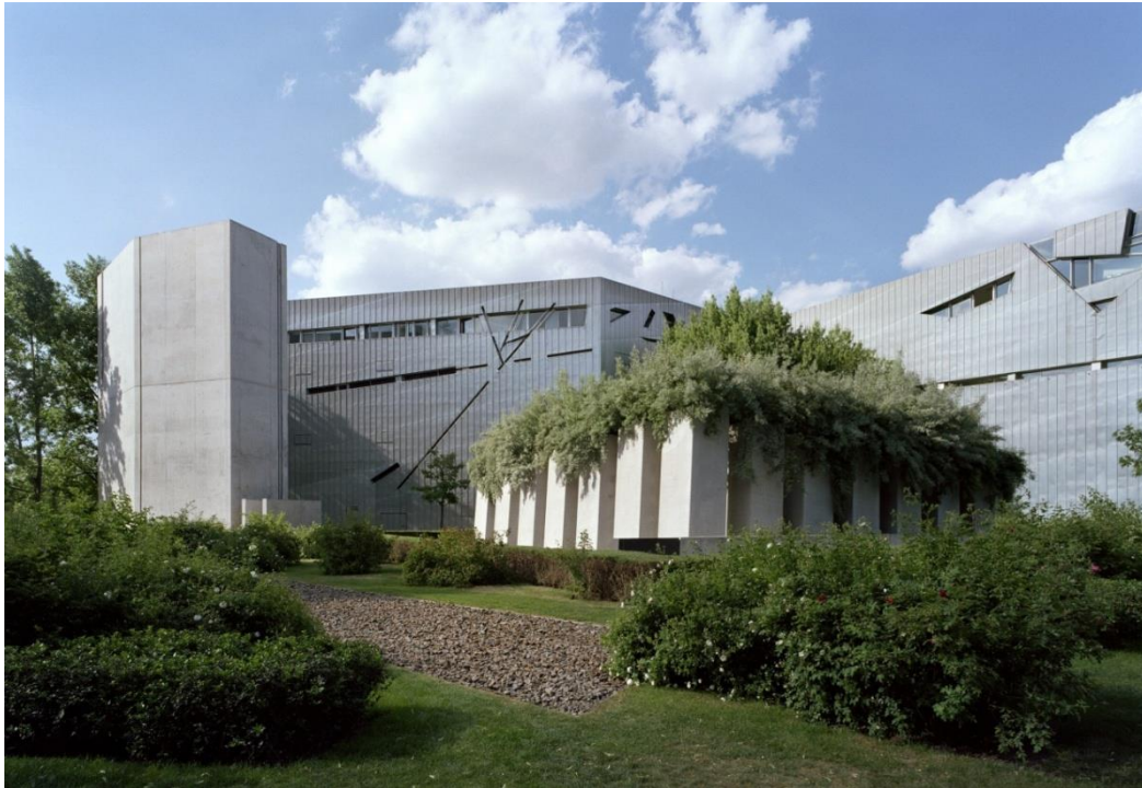
Εικ. 24. Άποψη του Κήπου της Εξορίας και της Μετανάστευσης σε σχέση με το κυρίως κτήριο και τον Πύργο του Ολοκαυτώματος.
