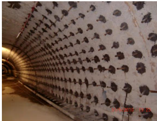
Εικόνα 9: Τοποθέτηση βλήτρων σε ημικυκλικό οχετό
