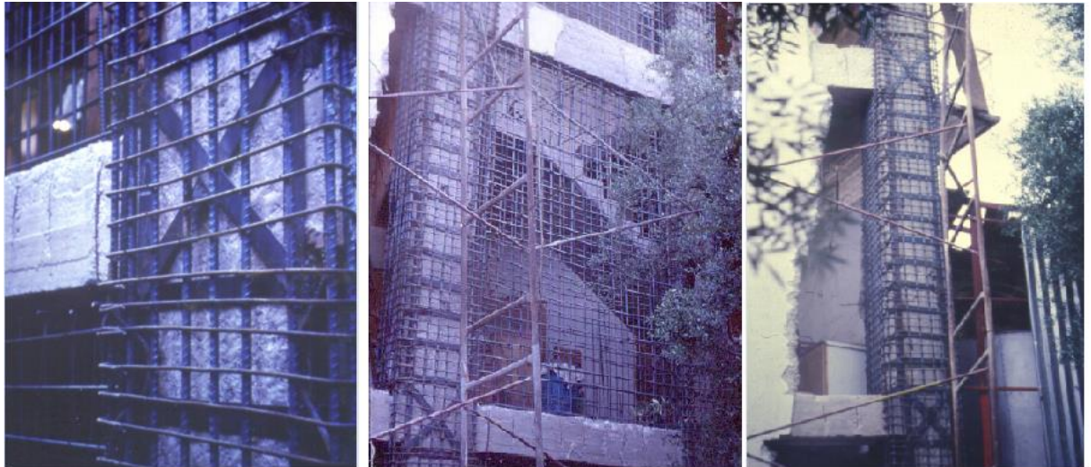
Εικόνα 13: Διπλή ενίσχυση με μεταλλικούς κλωβούς και μανδύες οπλισμού καθώς και εφαρμογή της μεθόδου των Χιαστί Κολλάρων για την ενίσχυση των κόμβων
