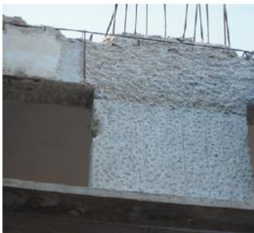
Εικόνα 7: Εκτράχυνση της επιφάνειας του οπλισμένου σκυροδέματος για την ανάπτυξη συνάφειας με τα υλικά της ενίσχυσης [20]
