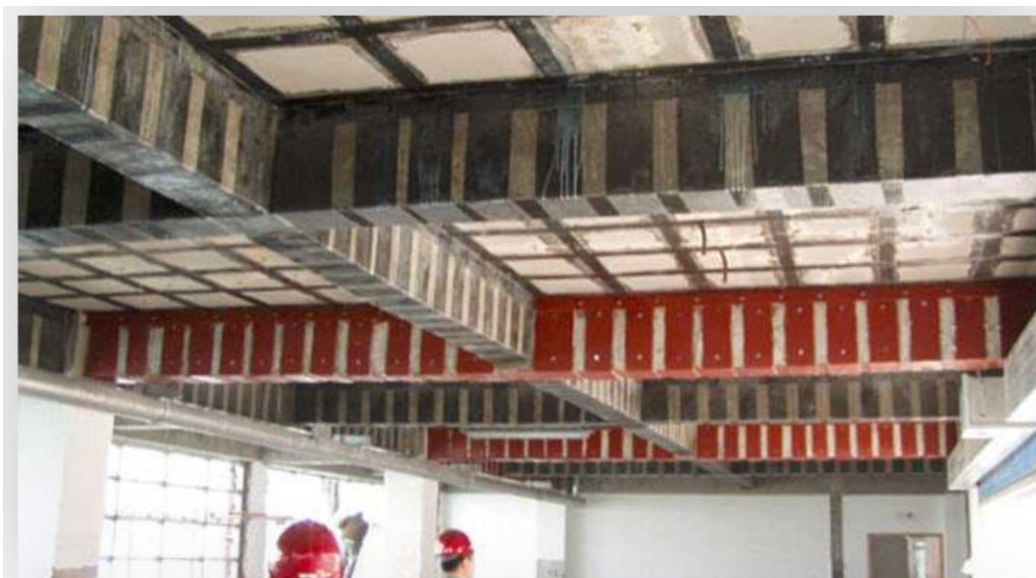
Εικόνα 12: Διατμητική ενίσχυση δοκού και πλάκας με πολυμερή και μεταλλικά ελάσματα.
