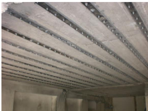
Εικόνα 11: Καμπτική ενίσχυση πλάκας
