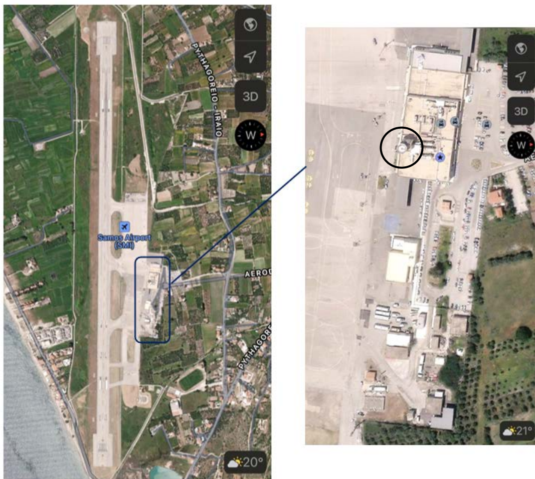
Εικόνα 37. Αεροφωτογραφία κρατικού αερολιμένα Σάμου από Apple Maps. Σε μαύρο κύκλο επισημαίνεται ο πύργος ελέγχου.
