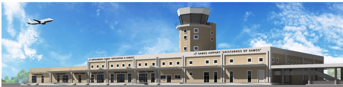
Εικόνα 36. Αεροσταθμός κρατικού αερολιμένα Σάμου
