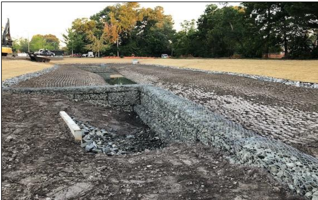
Σχήμα 2-5: Λίμνη συγκράτησης υδάτων κατά την φάση της κατασκευής, Virginia Beach (Πηγή: Vinicius J. et al. 2022)
