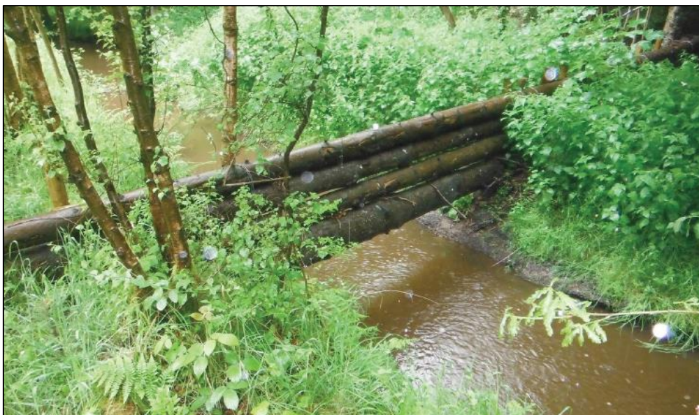
Σχήμα 2-7: Όψη ενός Leaky Barrier τοποθετημένο επί του ρου του ποταμού (Πηγή: Kali Rubaii et al. 2023)
