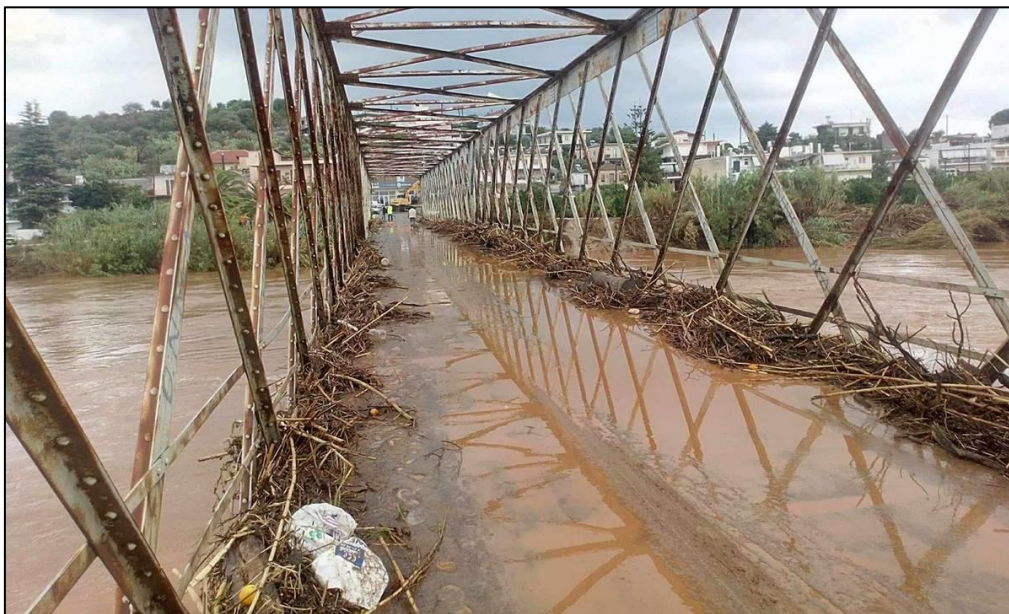
Σχήμα 3-19: Γέφυρα Σκάλας Λακωνίας σε περίοδο αυξημένων απορροών του ποταμού Ευρώτα
