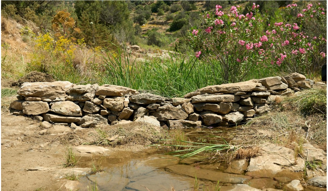
Εικόνα 7. Ολοκληρωμένο μικροφράγμα κατά μήκος του Καβουροπόταμου στην Πάρο, πηγή: Δ.Ε.Υ.Α.Π. Πάρου, « Ξερολιθικές υποδομές για την αντιμετώπιση της λειψυδρίας»
