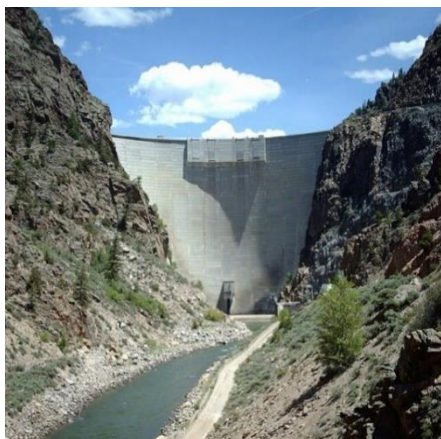
Εικόνα 2.39: Τοξωτό φράγμα Morrow Point (Από en.wikipedia.org)
