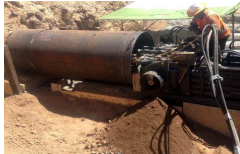
Εικόνα 2.34: Κεφαλή μηχανήματος ατέρμονα κοχλία κατά την εγκατάσταση (Από Γκούτης κ.ά.,2021)
