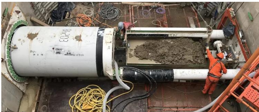
Εικόνα 2.27: MicroTBM στο φρέατο εισόδου (Από sika.com)
