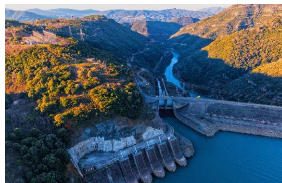
Εικόνα 2.49: Φράγμα Κρεμαστών (Από https://www.agrinionews.gr/ )
