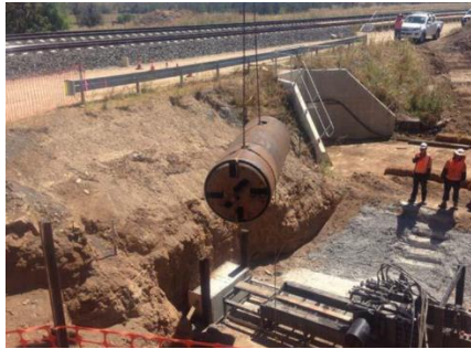
Εικόνα 2.33: Κεφαλή μηχανήματος ατέρμονα κοχλία κατά την τοποθέτηση (Από Γκούτης κ.ά.,2021)
