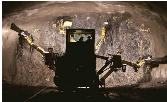
Εικόνα 2.4: Εκμηχανισμένη διάτρηση (Από Tunnel Business Magazine)
