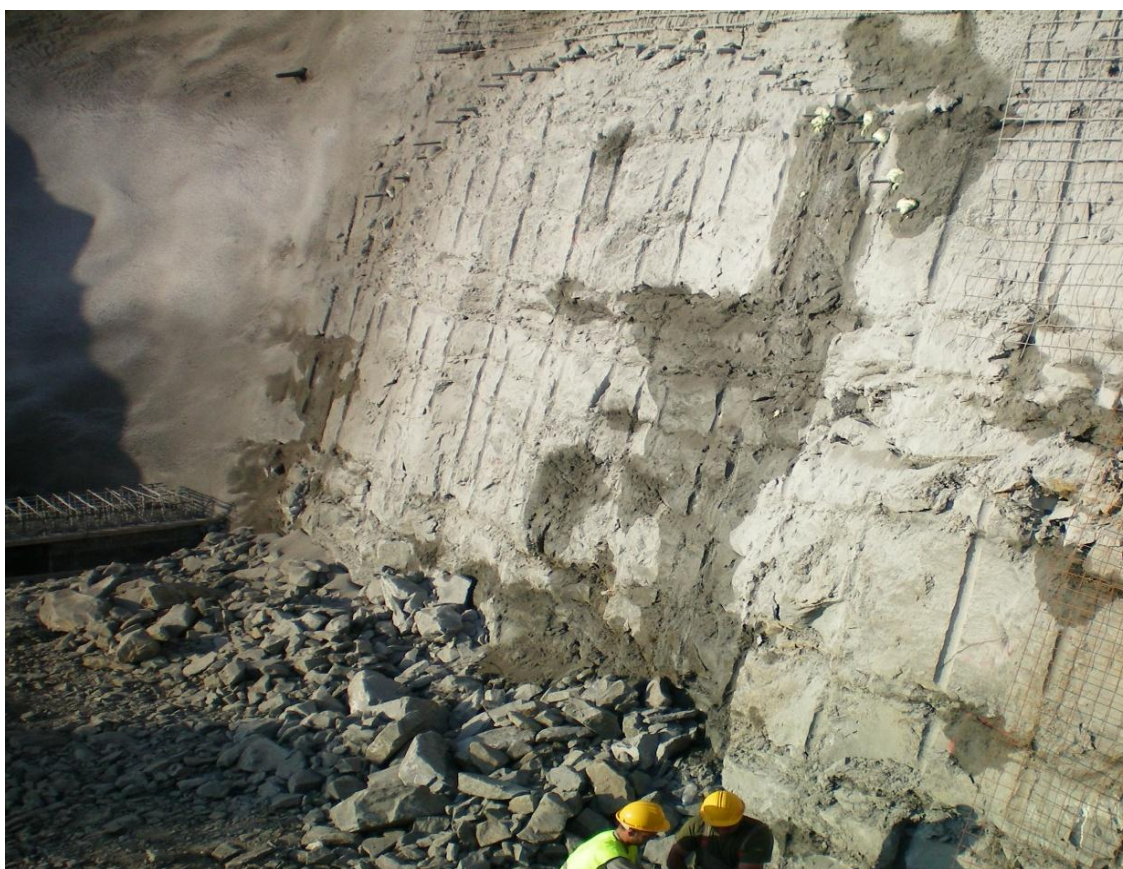
Εικόνα 3.8: Τοποθετημένοι ράβδοι προπορείας στην κορυφή του στομίου εισόδου
