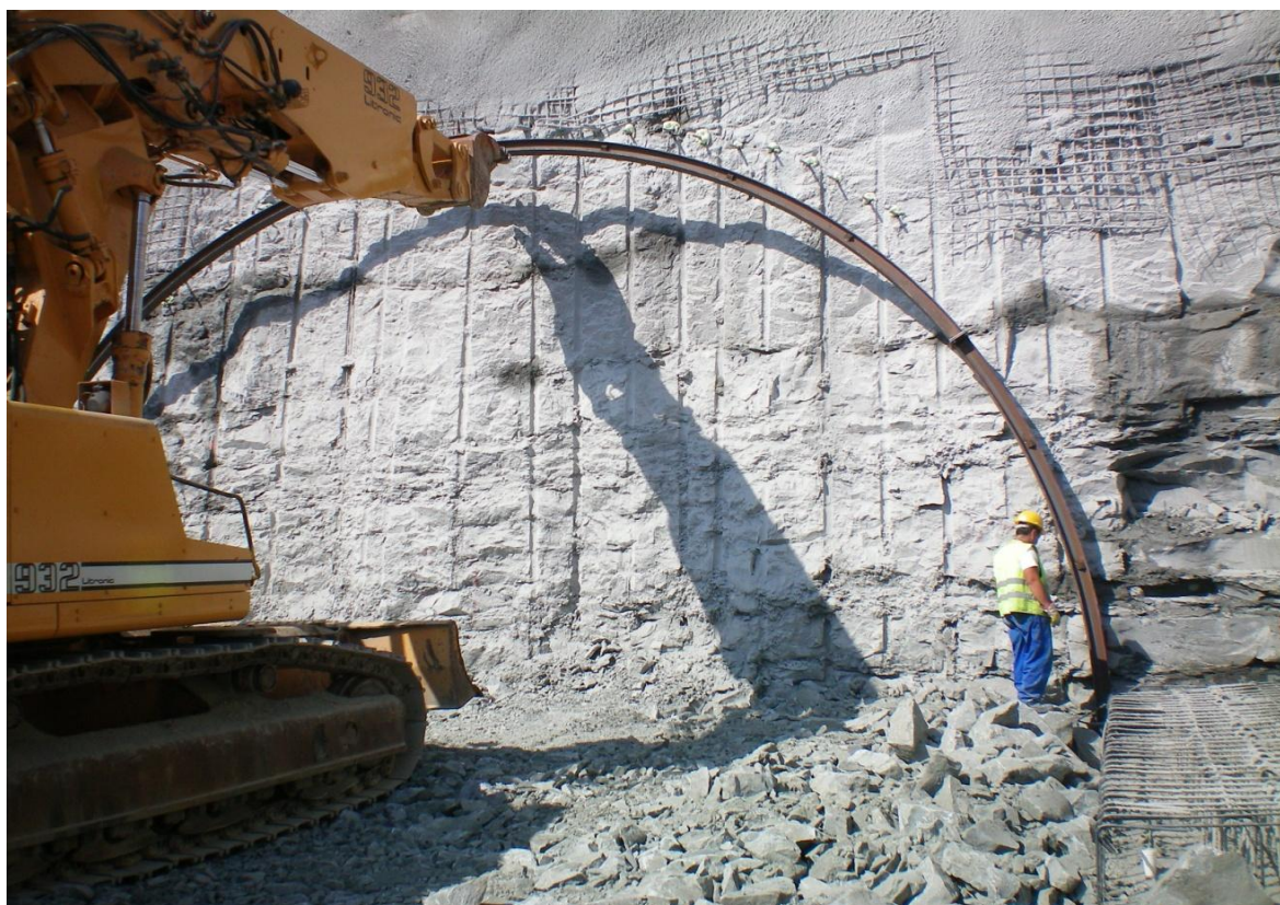
Εικόνα 3.6: Ανέγερση πλαισίου με χρήση τσάπας
