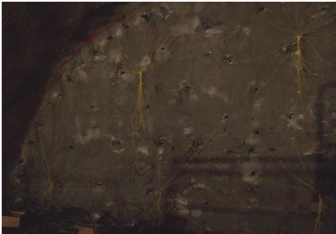
Εικόνα 6.8: Ολοκλήρωση εργασιών συνδεσμολογίας του κυκλώματος έναυσης
