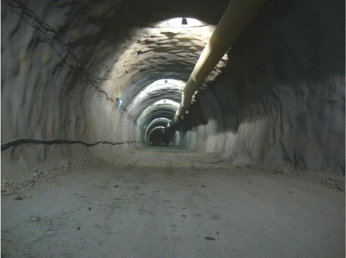
Εικόνα 3.3: Σήραγγα Καλυδώνας υποστηριγμένη με εκτοξευόμενο σκυρόδεμα (β' φάση)
