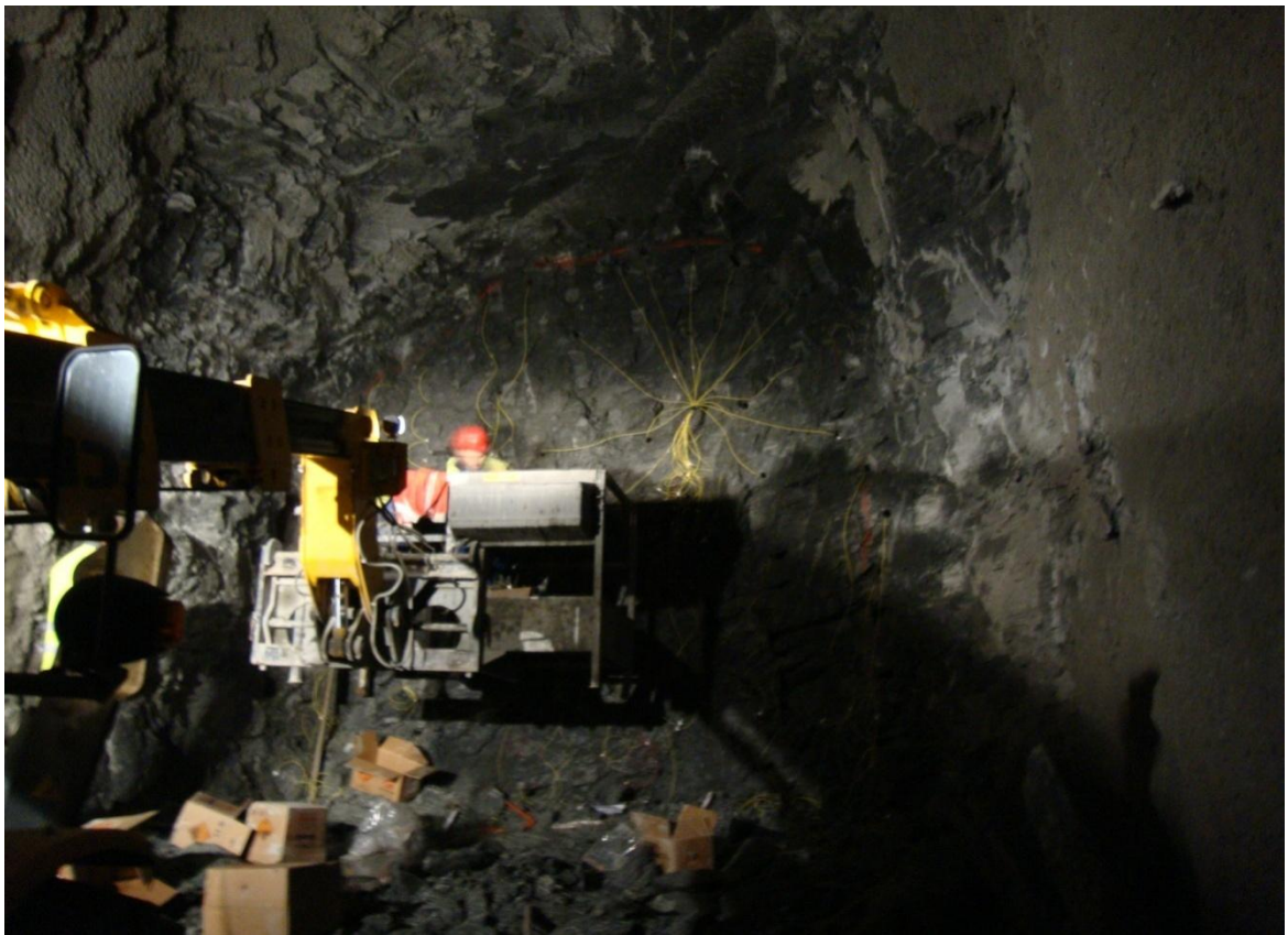
Εικόνα 6.7: Σύνδεση του κυκλώματος έναυσης
