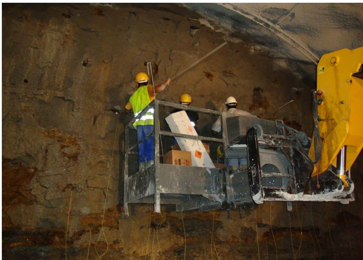
Εικόνα 6.5: Γόμωση διατρημάτων με ξύλινο τακαδόρο
