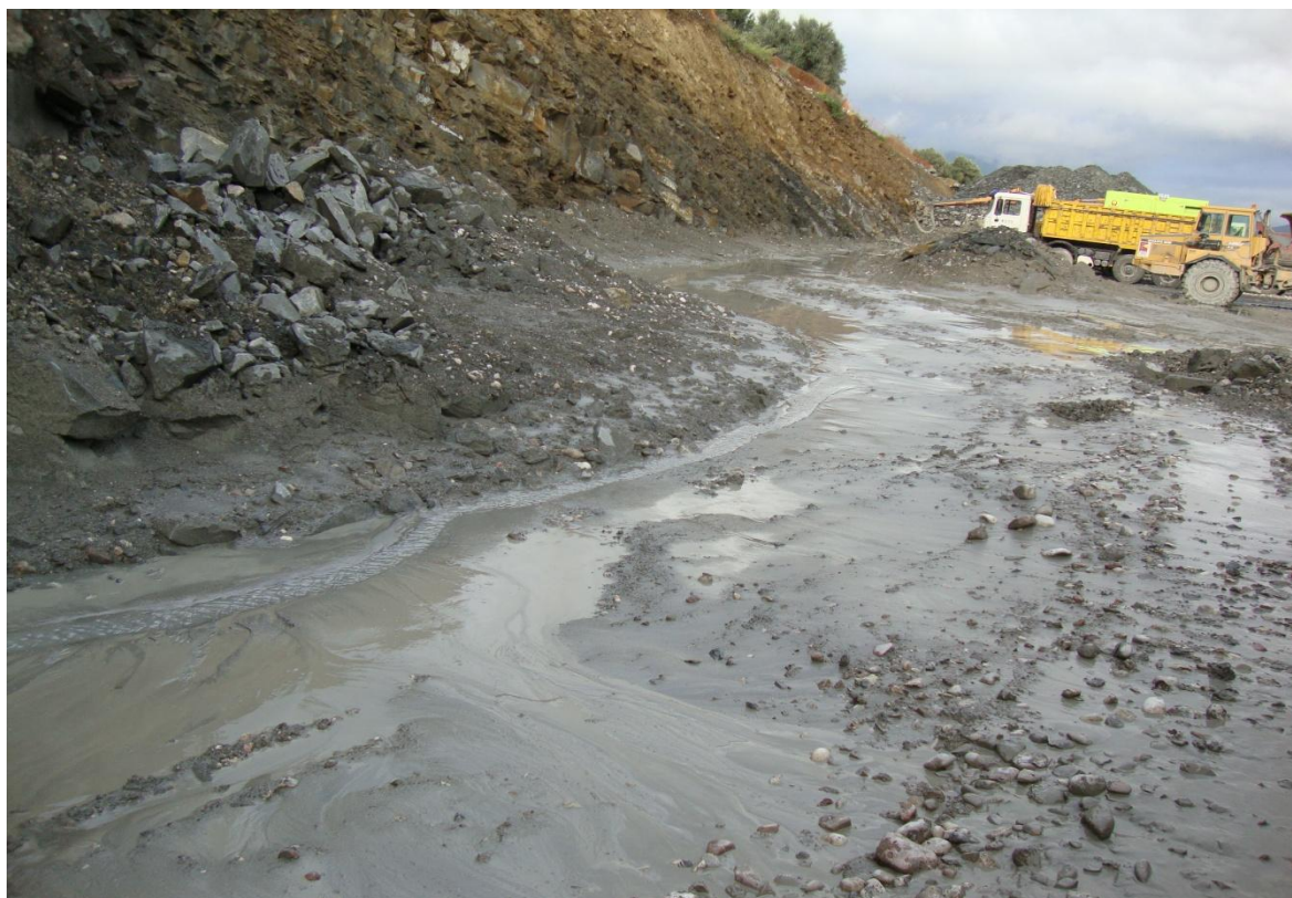
Εικόνα 2.6: Ύδατα οδηγούμενα μέσω ειδικών καναλιών έξω από τη σήραγγα (δεξιός κλάδος)
