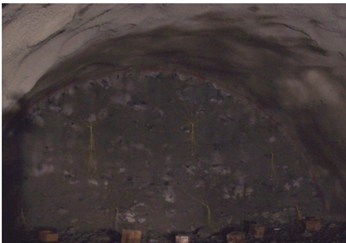
Εικόνα 6.9: Μέτωπο σήραγγας έτοιμο προς ανατίναξη
