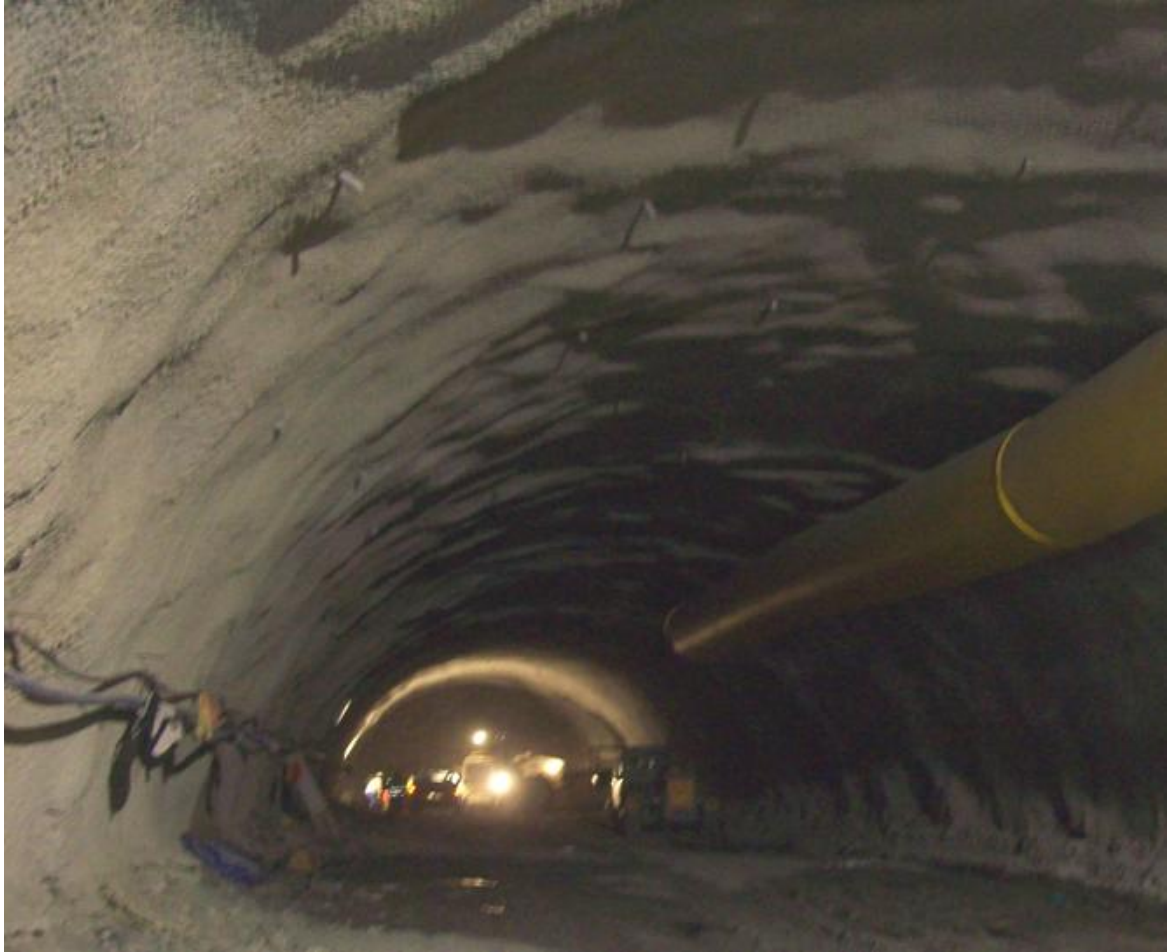
Εικόνα 3.4: Τοποθετημένα αγκύρια πακτωμένα με τσιμεντένεμα στην οροφή της σήραγγας
