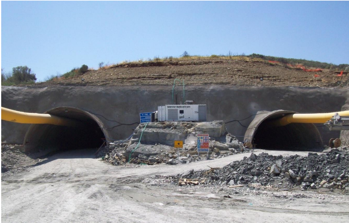
Εικόνα 1.1: Δίδυμη οδική σήραγγα Καλυδώνας (α' φάση εκσκαφής)
