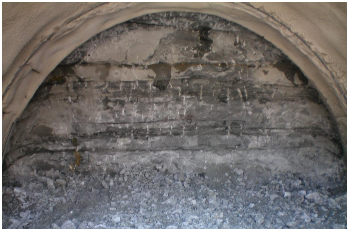
Εικόνα 2.4: Φλύσχη με εναλλαγές ψαμμίτη και ιλυόλιθου κατα τη διάνοιξη της σήραγγας
