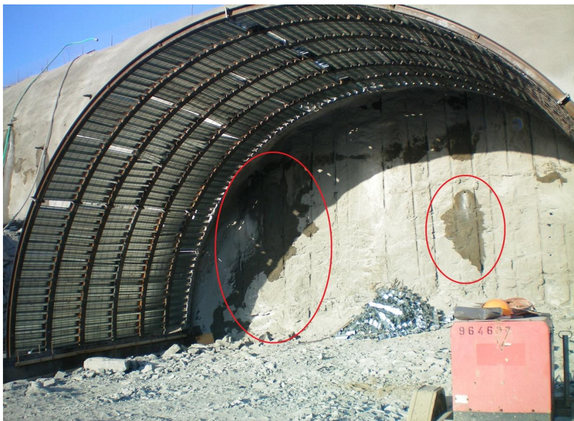
Εικόνα 2.5: Μικρή υδροφορία στο στόμιο εισόδου της σήραγγας (αριστερός κλάδος)
