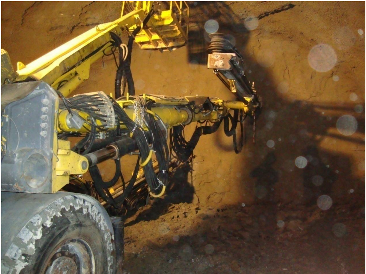
Εικόνα 6.2: Διάτρηση μετώπου (κάνναβος διατρημάτων)
