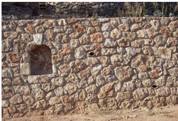
Εικόνα 18: Λιθοδομή από αργούς λίθους
