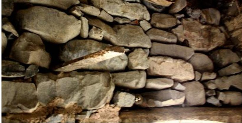
Εικόνα 19: Ξηρολιθοδομή
