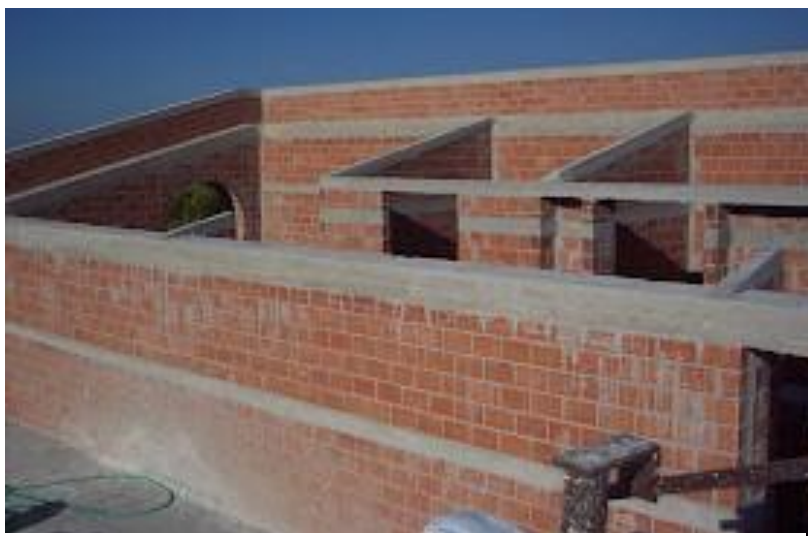
Εικόνα 36: Οριζόντια διαζώματα από οπλισμένο σκυρόδεμα (σενάζ) https://grafei-o-oikodimos.blogspot.com/2012/12/blog-post_482.html
