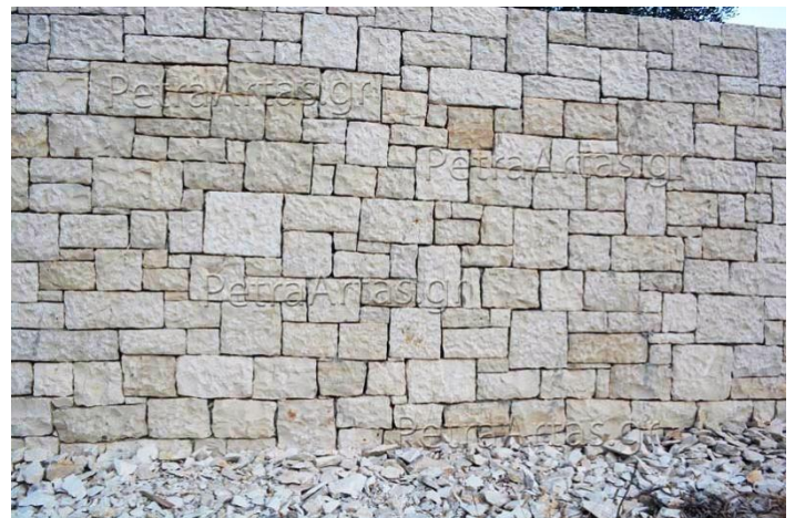
Εικόνα 16: Λιθοδομή από λαξευτούς λίθους
