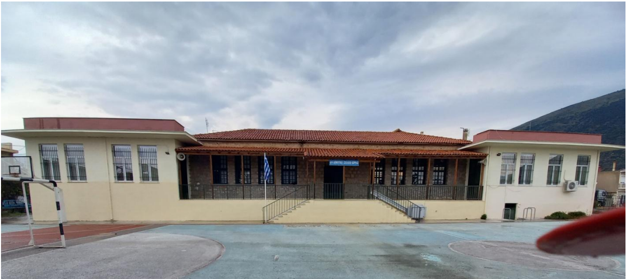
Εικόνα 38: Φωτογραφία σημερινής κατάστασης
