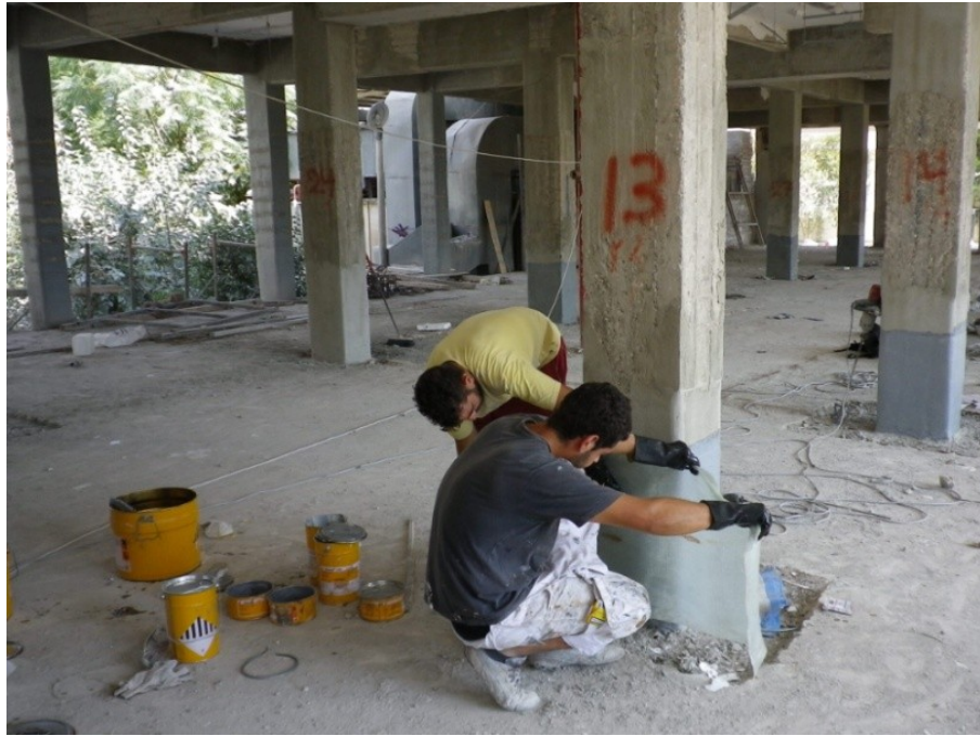
Εικόνα 4.4-1. Ενίσχυση σκυροδέματος με επένδυση ανθρακούφασματος (Πηγή: https://dynamochrom.gr/ ).
