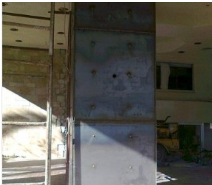
Εικόνα 4.8.4-1. Περίσφιξη με μεταλλικό κλωβό από φύλλα χάλυβα (Πηγή: https://daskalakis-xania.gr/ ).
