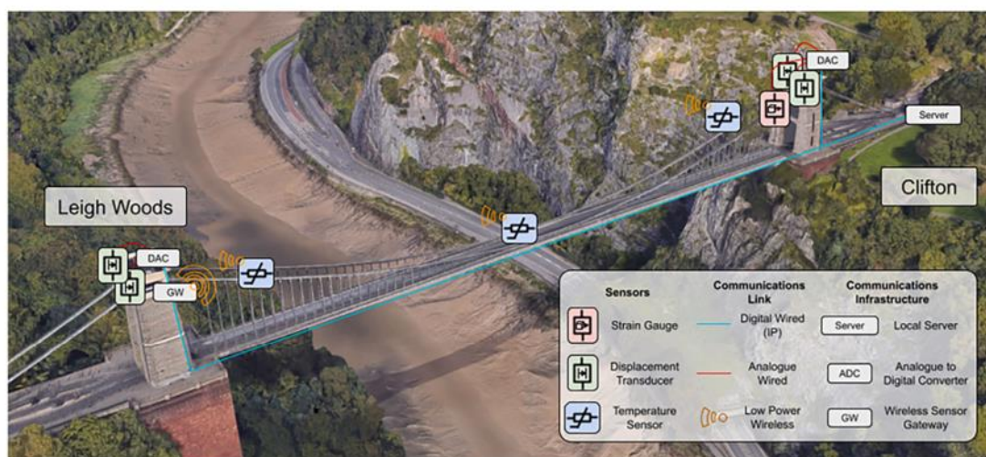
Σχήμα Π.2 : Οι τοποθετημένοι αισθητήρες στην κρεμαστή γέφυρα Clifton, Prengolato et al., 2022
