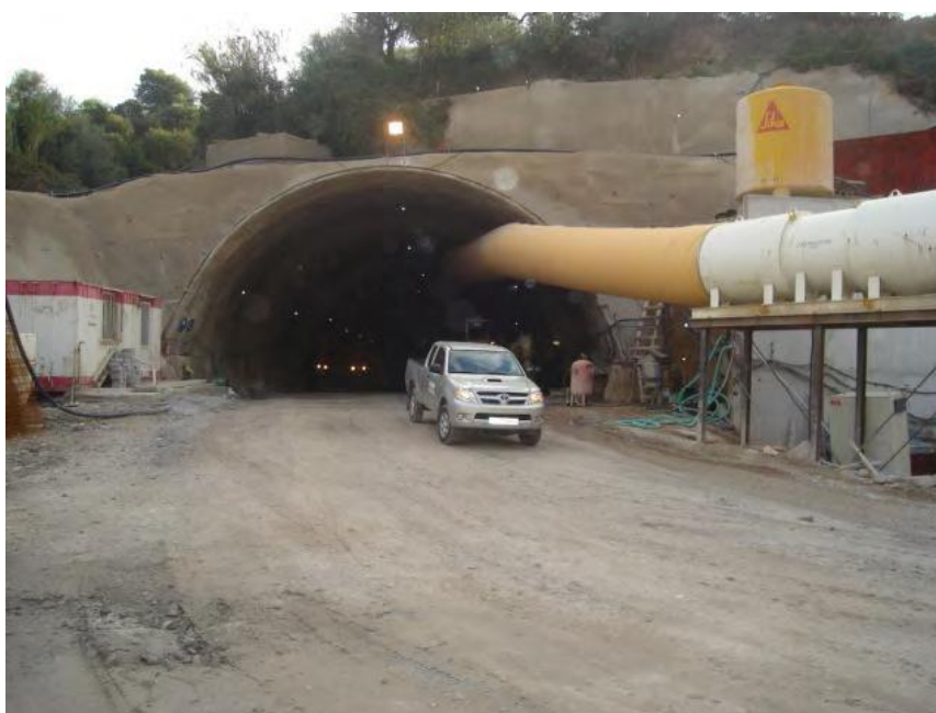
Εικόνα 3. Έξοδος κύριας σήραγγας Πλατάνου (Πηγή:ΕΡΓΟΣΕ)
