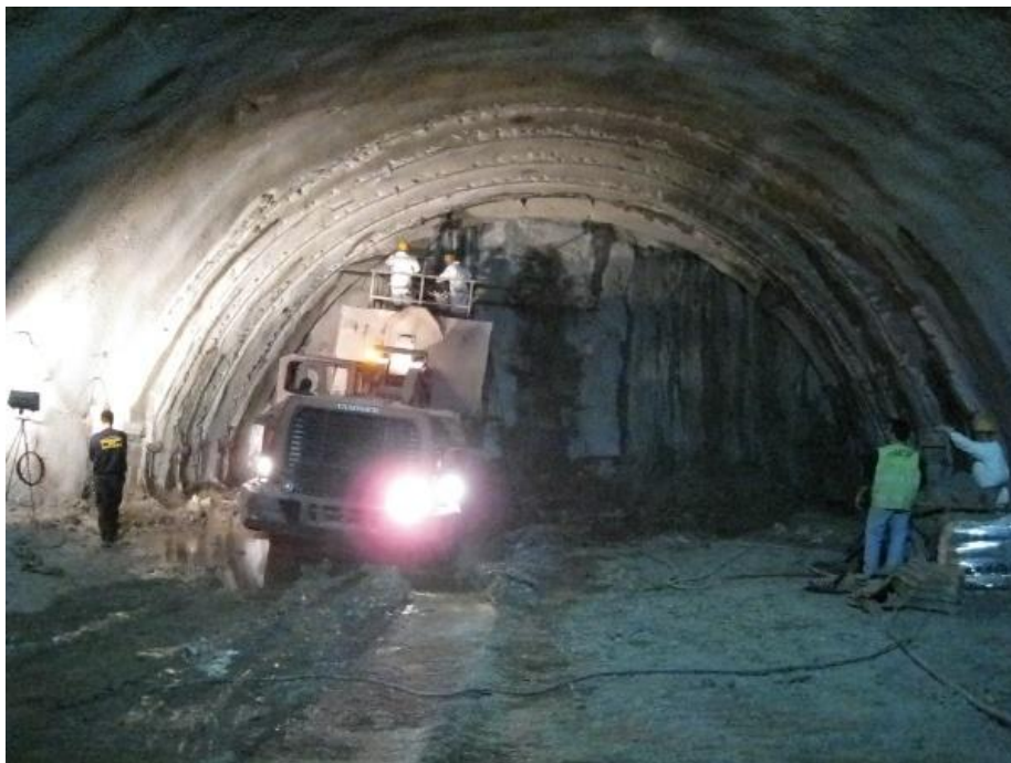
Εικόνα 5. Σήραγγα Πλατάνου - Χρήση εκρηκτικών (Πηγή: ΕΡΓΟΣΕ)
