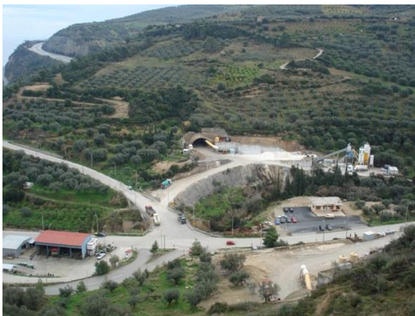
Εικόνα 2. Εργοτάξιο Πλατάνου-Τράπεζας (Πηγή:ΕΡΓΟΣΕ)
