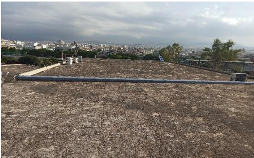
Εικόνα 6: Οροφή του κτιρίου “Α” από οπλισμένο σκυρόδεμα
