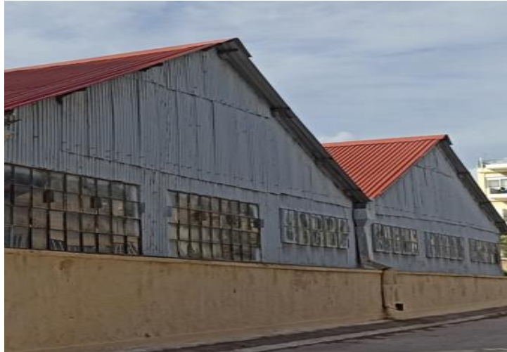
Εικόνα 13: Πλάγια δεξιά όψη του κτιρίου “Δ”
