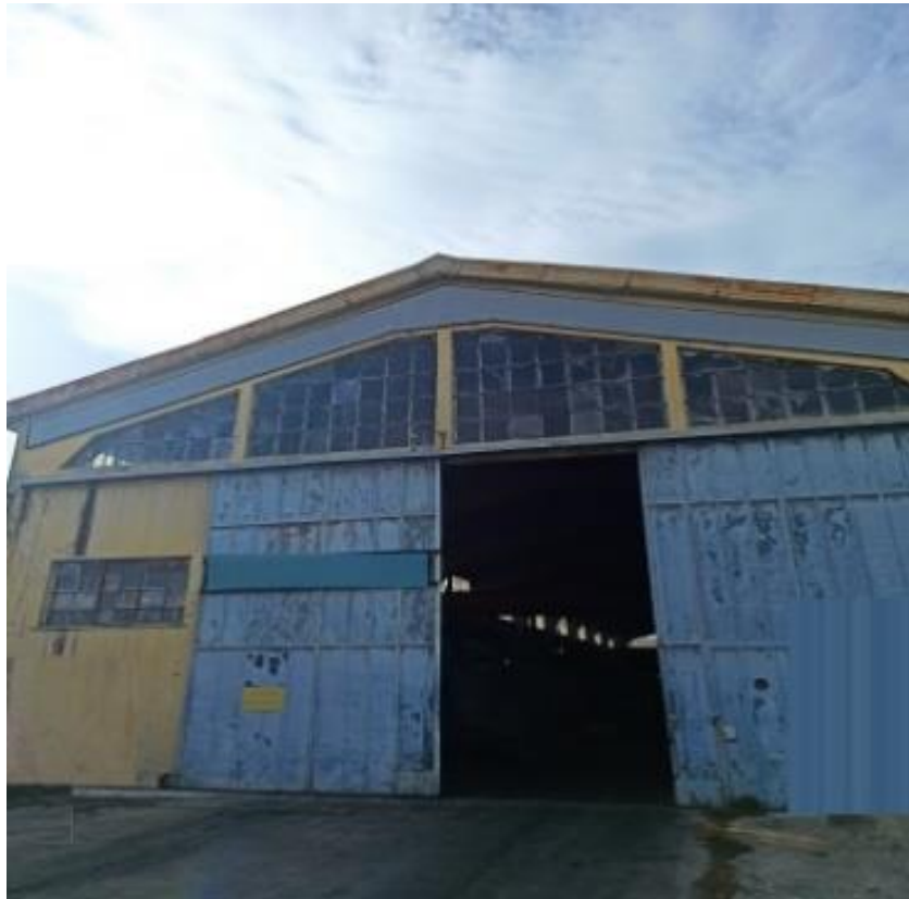
Εικόνα 10: Πρόσοψη του κτιρίου “Γ”
