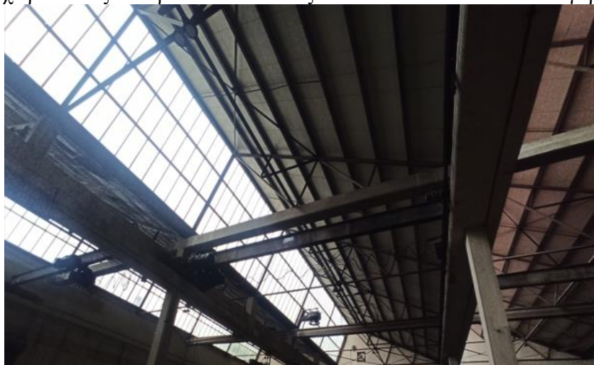
Εικόνα 16: Μορφή και είδος υλικού της οροφής του κτιρίου “Ε”
