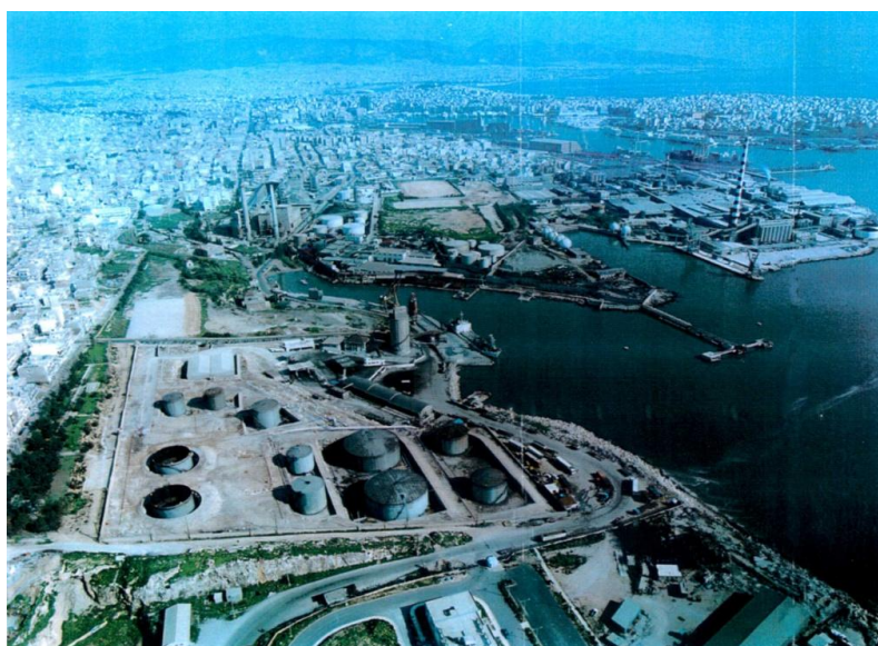
Εικόνα 5-1 : Η περιοχή ανάπλασης πριν την κατεδάφιση του εργοστασίου Λιπασμάτων
