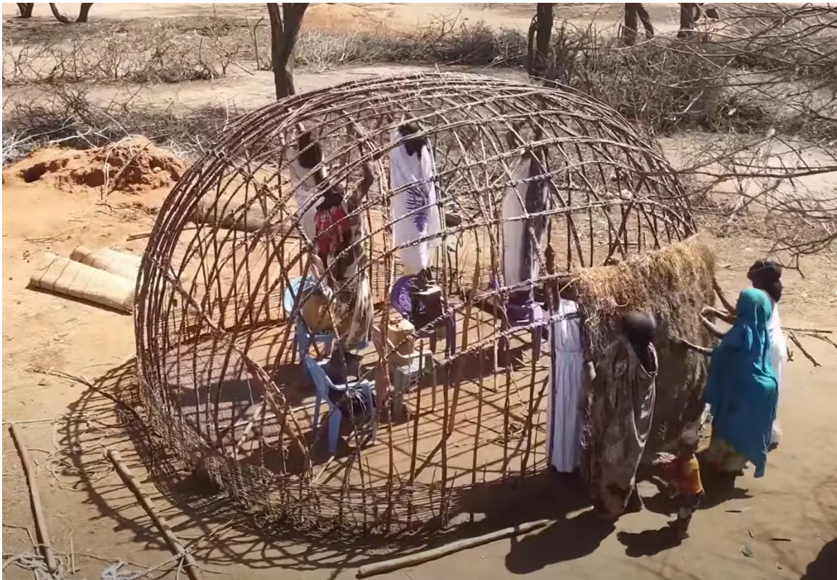
Εικόνα 11. Κατασκευή φέροντος πλέγματος και κρέμασμα των πλεκτών επιφανειών.
