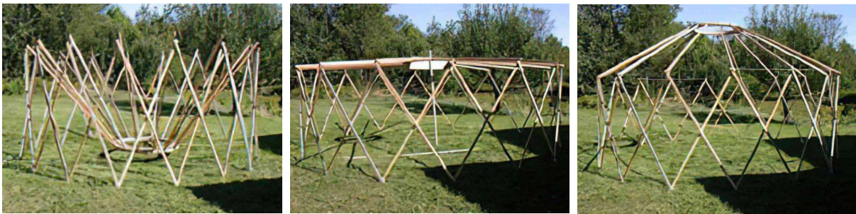
Εικόνα 44. Εικόνες από το στήσιμο της φέρουσας κατασκευής
