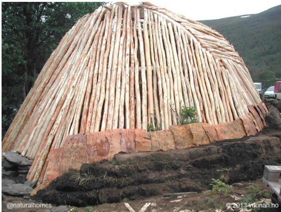
Εικόνα 33. Ανακατασκευή μόνιμου γκοάχτι καλυμμένου με τύρφη
