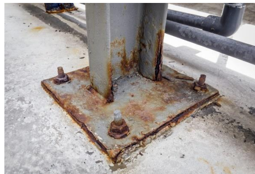
Σχήμα 2.7. Διάβρωση χαραγής.
