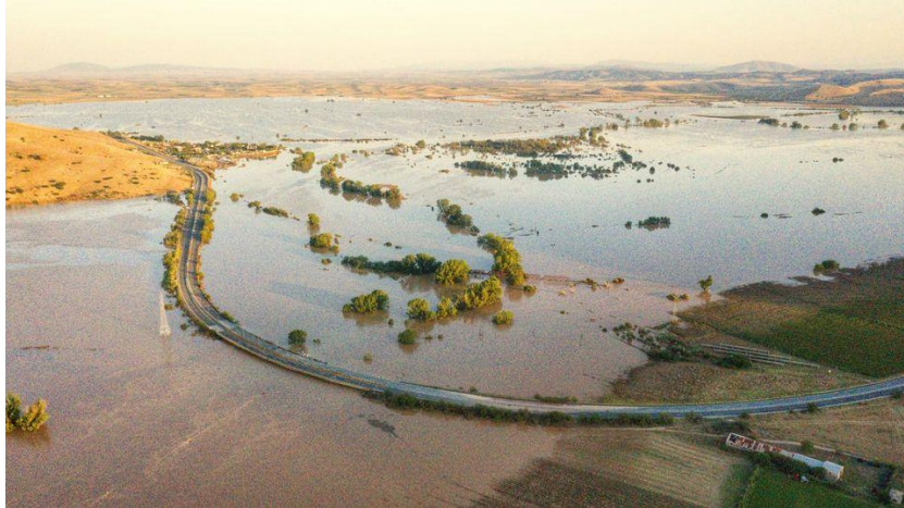
Σχήμα 6.2. Άποψη της γέφυρας μετά τις πλημμύρες του Σεπτεμβρίου 2023.
