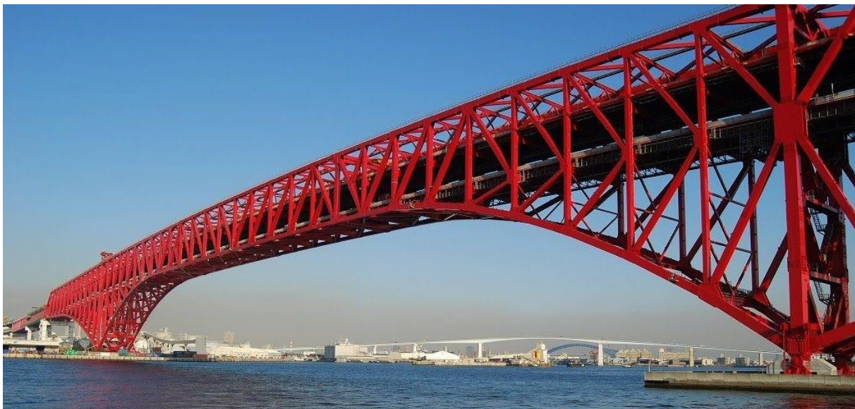
Σχήμα 1.17 Minato Bridge, Osaka, Japan (1974)
