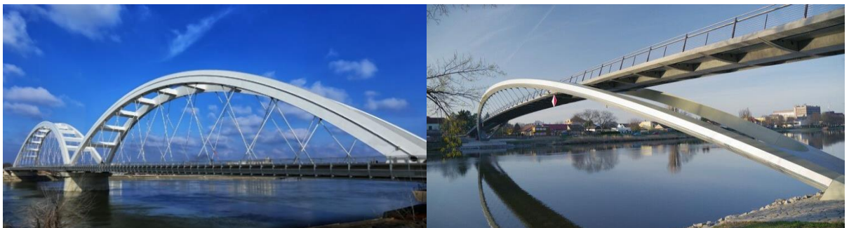
Σχήμα 1.9 Γέφυρα με τόξο-ελκυστήρα & Γέφυρα με κεκλιμένα τόξα
