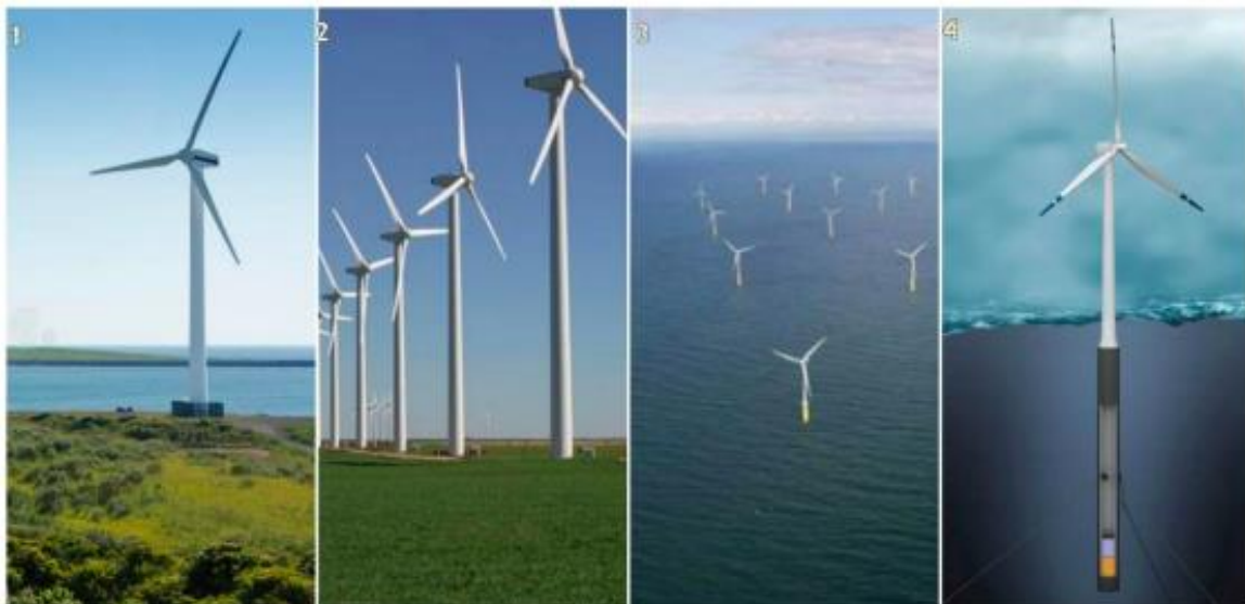
Εικόνα 4 Πρώτη εικόνα: παράκτιο αιολικό πάρκο. Δεύτερη εικόνα: χερσαίο αιολικό πάρκο. Τρίτη εικόνα: υπεράκτιο αιολικό πάρκο. Τέταρτη εικόνα: πλωτό αιολικό πάρκο
