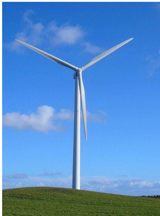
Εικόνα 1 Ανεμογεννήτρια οριζόντιου άξονα.
