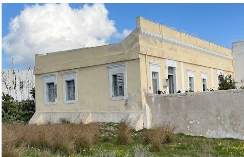
Εικόνα 5-1: Όψη ισογείου υπό μελέτη κτηρίου.
