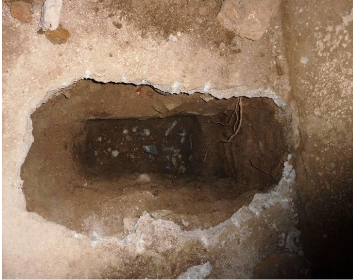
Εικόνα 2-4: Σκάμμα διερεύνησης θεμελίωσης τοίχου.
