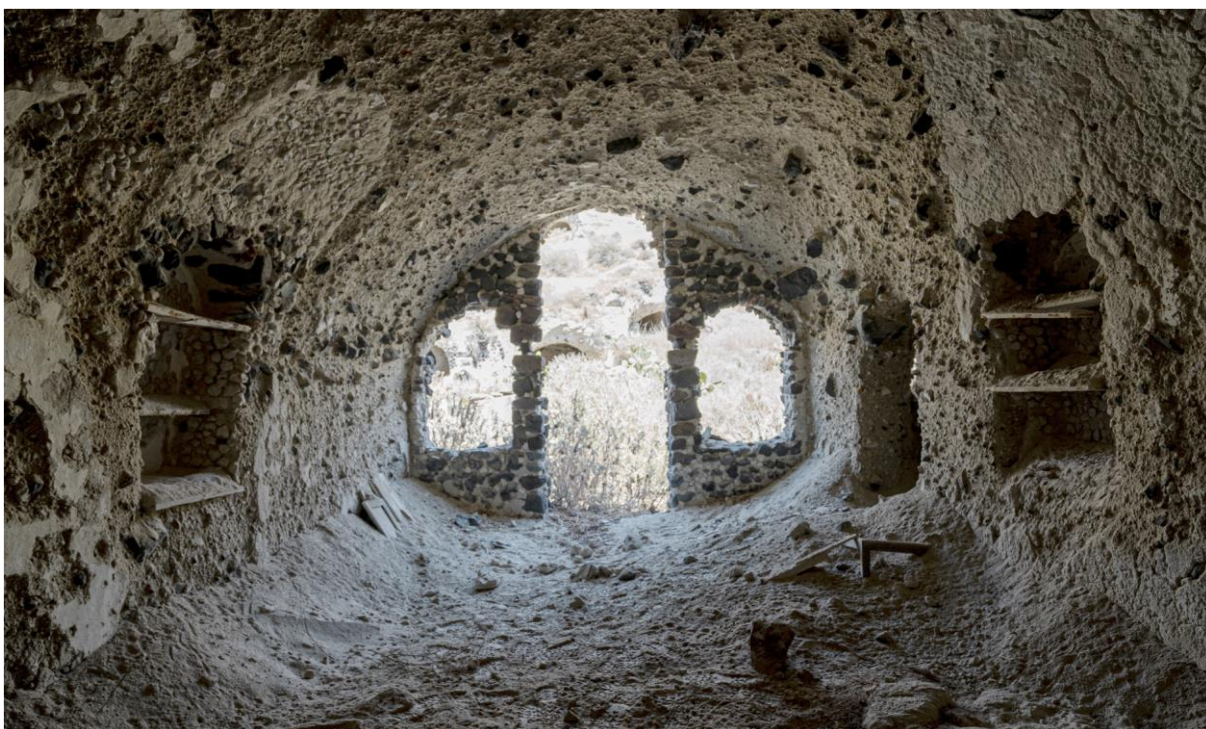
Εικόνα 1-1: Εσωτερική άποψη υπόσκαφου κτίσματος (Πηγή: Εγχειρίδιο για τις θηραϊκές τεχνικές δόμησης ).
