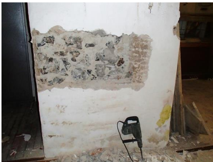
Εικόνα 2-2: Διερεύνηση της μορφής δόμησης της λιθοδομής.
