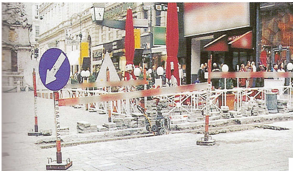
Ασφαλής περίφραξη και σήμανση εργοταξίου
