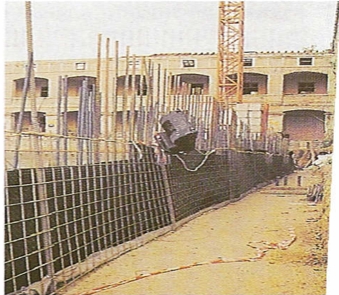
Ασφαλής εσωτερική περίφραξη εργοταξίου εκσκαφής.
