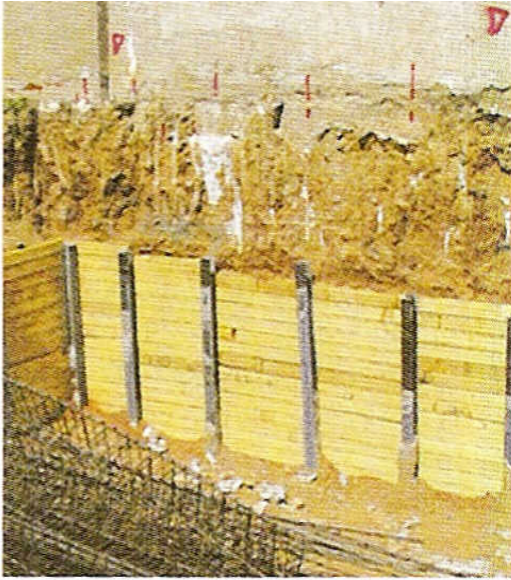
Αντιστήριξη θεμελίων κτιρίου
