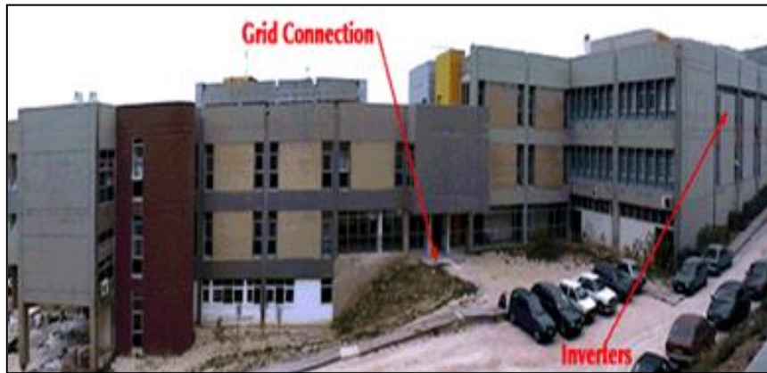
Σχήμα 4.8: Τοποθέτηση Inverters και Υ/Σ τροφοδοσίας
