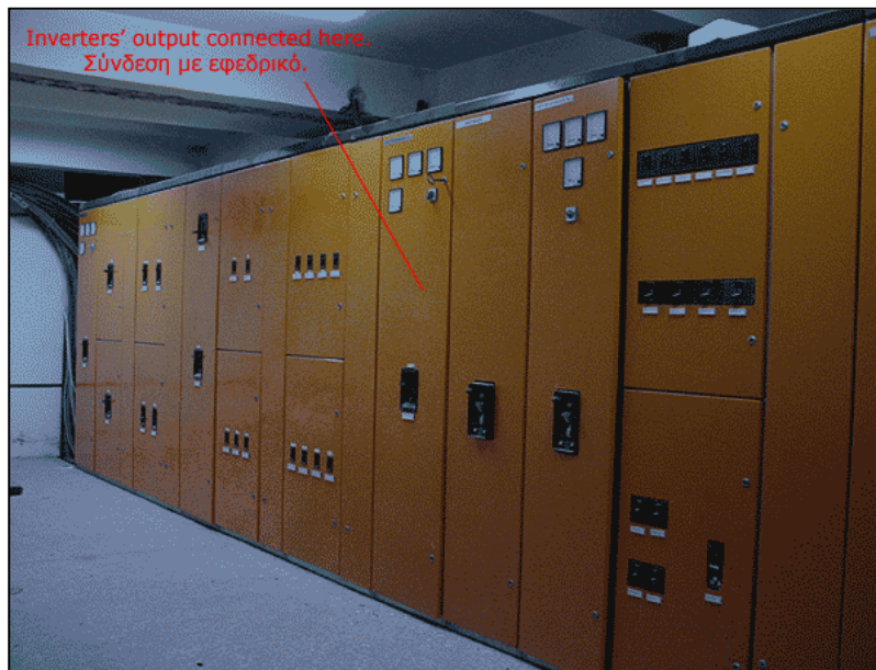
Σχήμα 4.7: Υ/Σ σύνδεσης των αντιστροφέων
