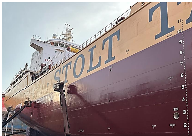
Εικόνα 30: Εργασίες επίστρωσης στο πλοίο Stolt Lotus
