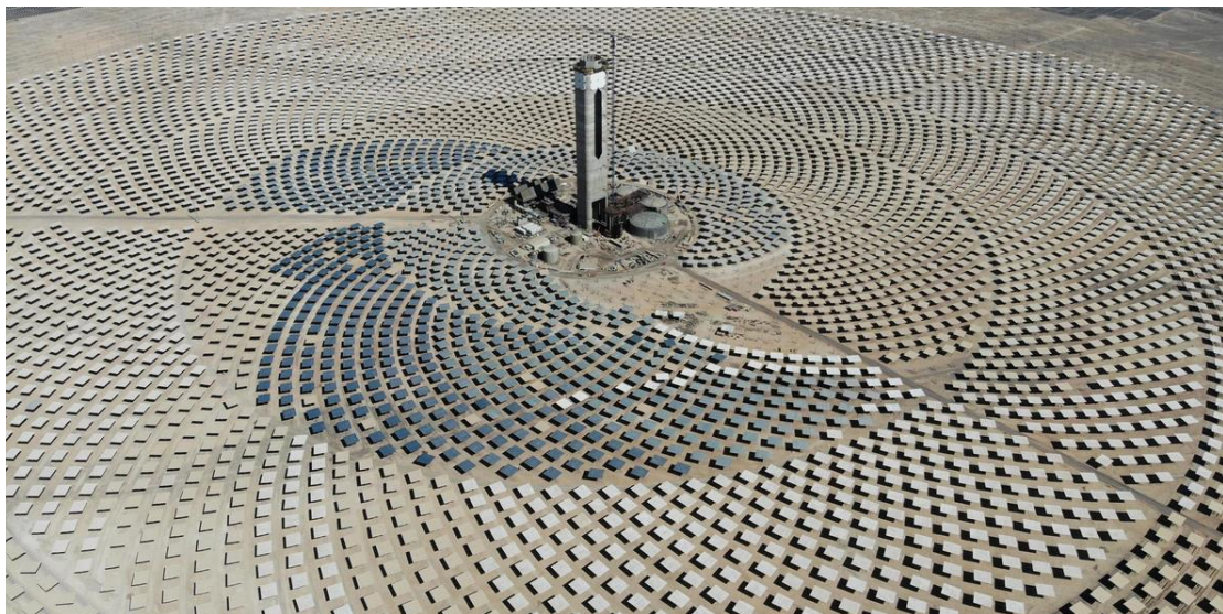
Εικόνα 4-5. Φωτοβολταϊκό σύστημα παραγωγής ηλεκτρικής ενέργειας Cerro Dominador στην περιοχή Antofagasta της Χιλής.
