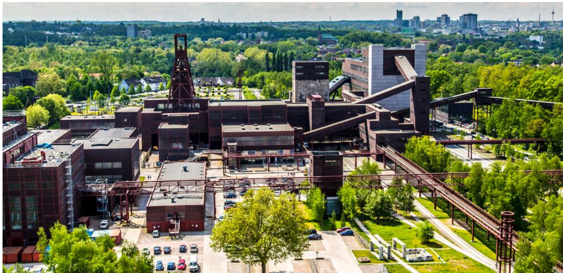
Εικόνα 4-1. Βιομηχανικό συγκρότημα του ορυχείου άνθρακα Zollverein, Essen, Γερμανία.
