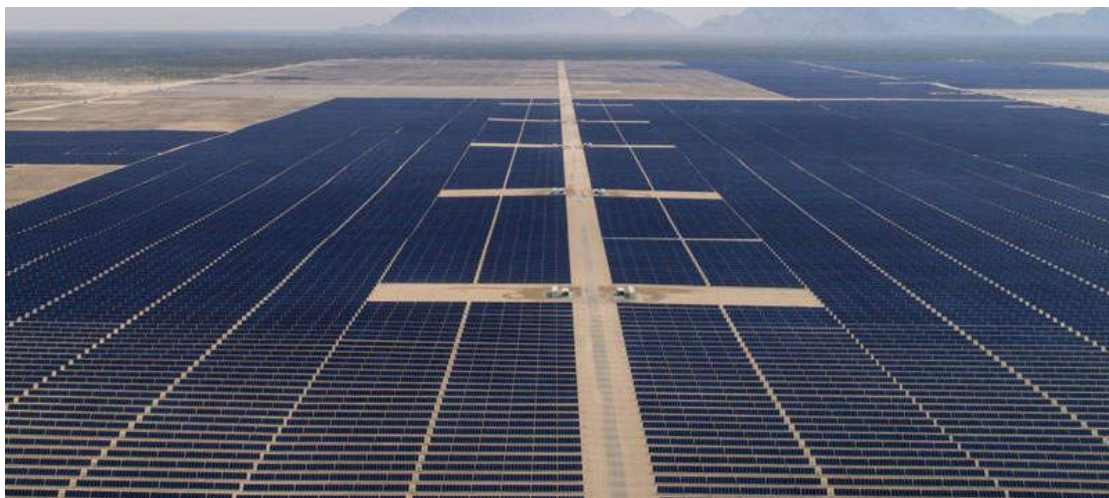
Εικόνα 4-7. Φωτοβολταϊκό πάρκο Villanueva, Viesca, Coahuila, Μεξικό.
