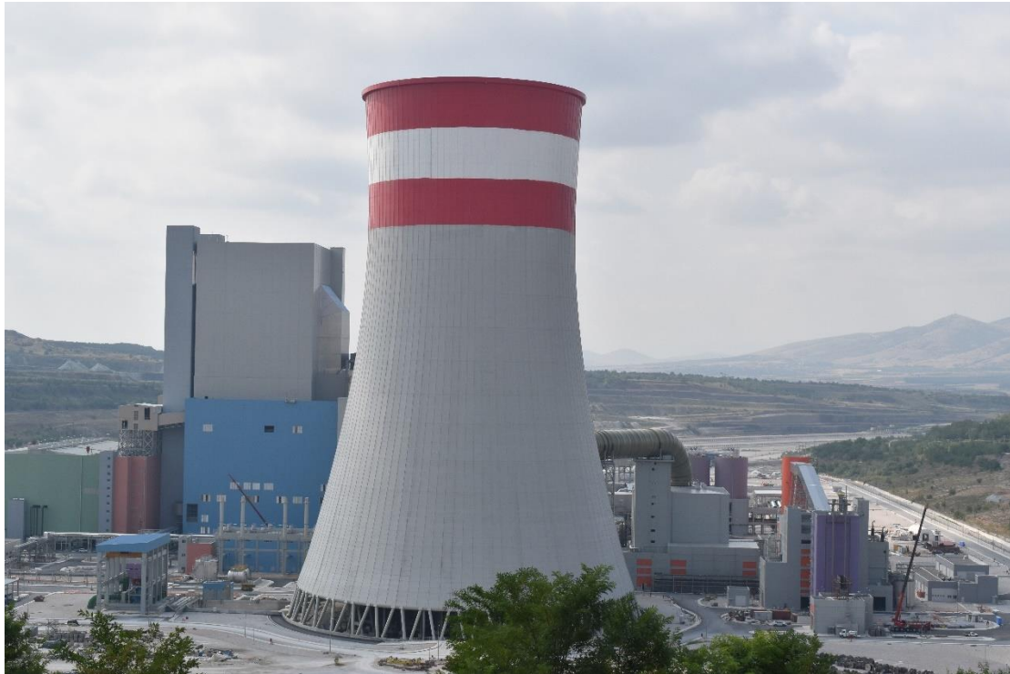
Εικόνα 7-10. Νέα μονάδα Πτολεμαΐδα-V, Δυτική Μακεδονία.
