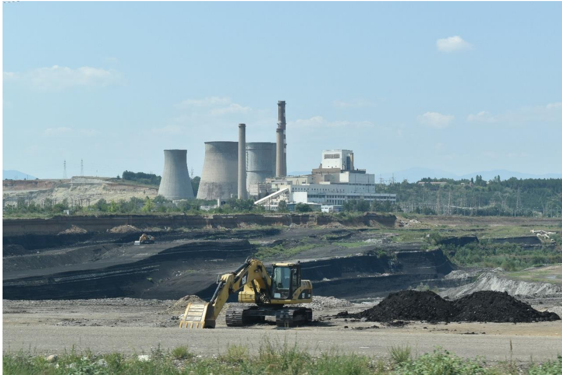
Εικόνα 7-13. Εκσκαφέας, ΛΚΔΜ, Δυτική Μακεδονία.
