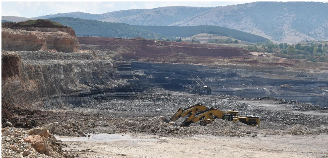
Εικόνα 7-14. Εκσκαφείς, αποθέτες και διαφορετικές βαθμίδες εκσκαφών, ΛΚΔΜ, Δυτική Μακεδονία.
