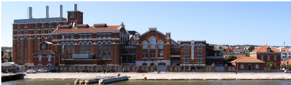
Εικόνα 4-3. Tejo Power Station, Πορτογαλία.
