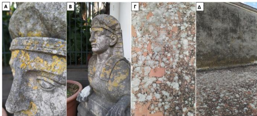
Εικόνα 29: Αποτελέσματα βιοδιάβρωσης και αισθητικής αλλοίωσης από την ανάπτυξη λειχήνων στις λίθινες επιφάνειες αγαλμάτων (A,B) και τοιχωμάτων (Γ,Δ) (Cozzolino et al., 2022).
