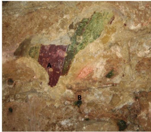
Εικόνα 7: Λεπτομέρειες φθαρμένης τοιχογραφίας από εσωτερικό τοίχο της Ιεράς Μονής Αγίας Παρθένου στη Σερβία, Α) Αποχρωματισμοί στην επιφάνεια της τοιχογραφίας, Β) Ρωγμές με εμφανή μικροβιακή ανάπτυξη (Stupar et al., 2014).
