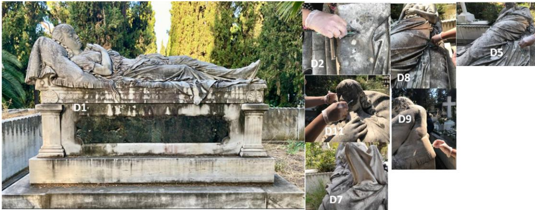
Εικόνα 48: Σημεία δειγματοληψίας από το Μνημείο Δελιγιάννη (Κοιμωμένη του Βιτσάρη), Α' Νεκροταφείο Αθηνών
